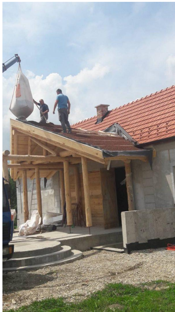
Slika 5.3. Izvedba kosog zelenog krova u Murskom Središću
