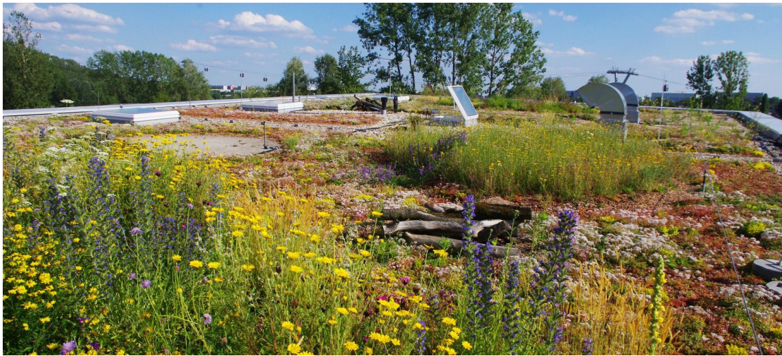
Slika 3.3. Izgled ekstenzivnog zelenog krova
