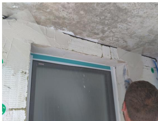
Slika 13. Postavljanje završnih profila
