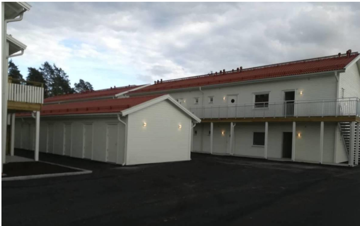
Slika br. 1.1.1. Stambeni kompleks od 3 montažne kuće koje se sastoje od 8 stambenih jedinica, lokacija: Švedska
