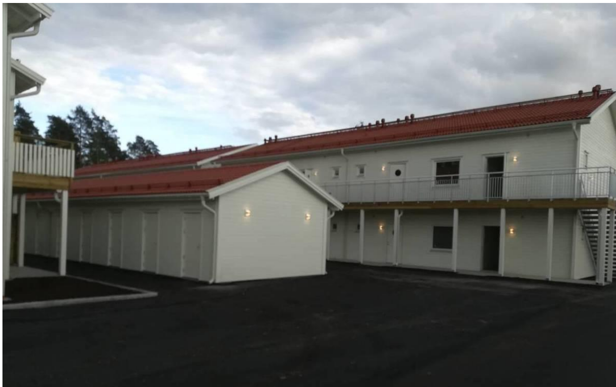
Slika br. 1.1.1. Stambeni kompleks od 3 montažne kuće koje se sastoje od 8 stambenih jedinica, lokacija: Švedska
