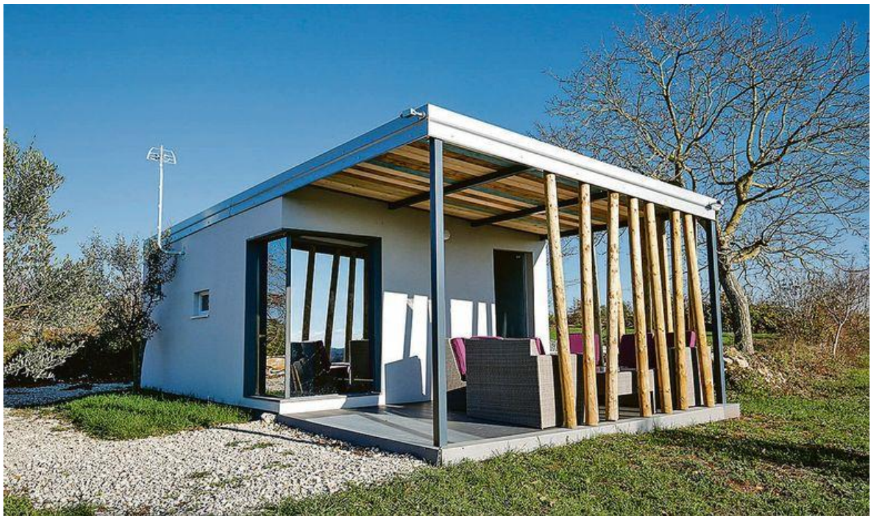
Slika 1.2.1. Primjer drvene montažne kuće u Istri
