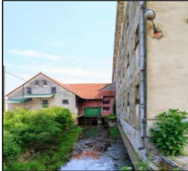
Slika 7. Postojeće stanje strojarnice izvana [21]
