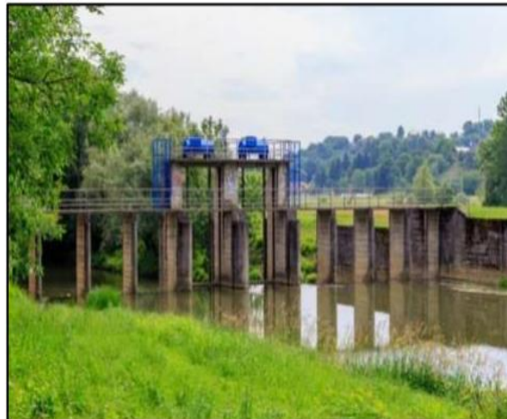
Slika 8. Brana Kućan Ludbreški [21]
