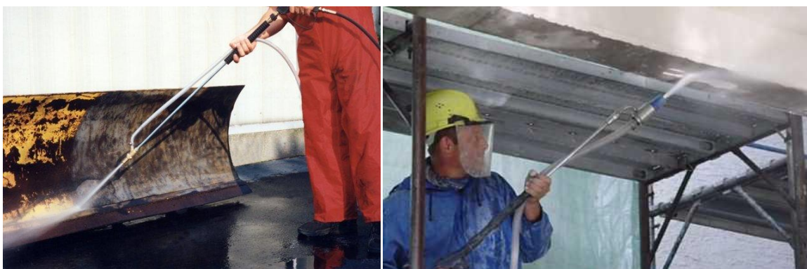
Slika 27. Priprema površine vodenim mlazom [52, 53]
