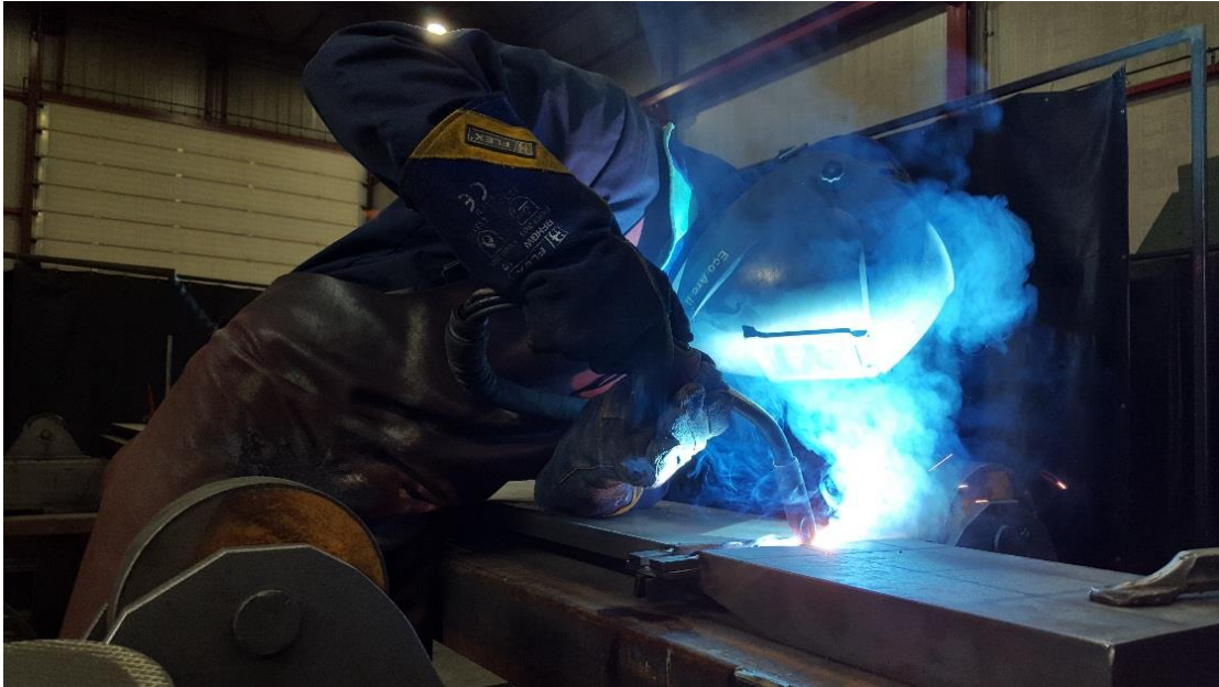
Slika 3: Prikaz zavarivača koji zavaruje MAG postupkom
