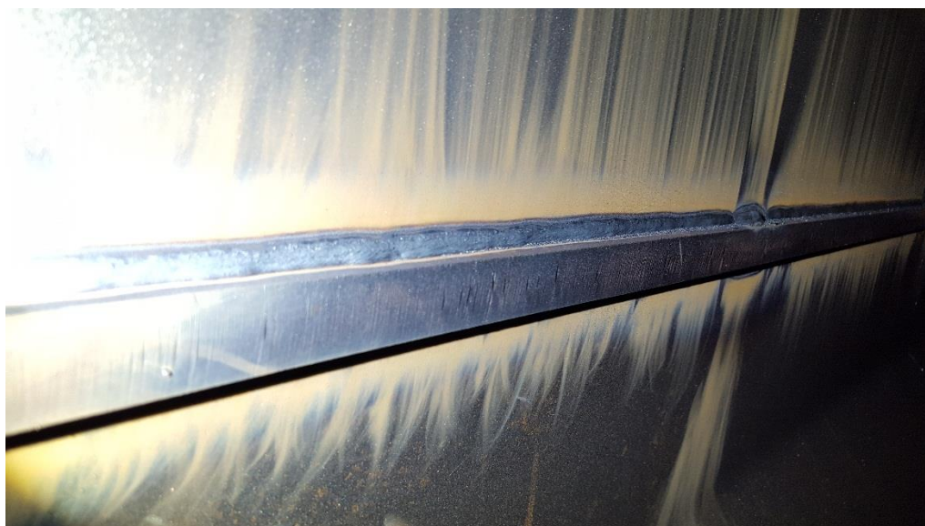
Slika 32: Kontrola provara s unutarnje strane
