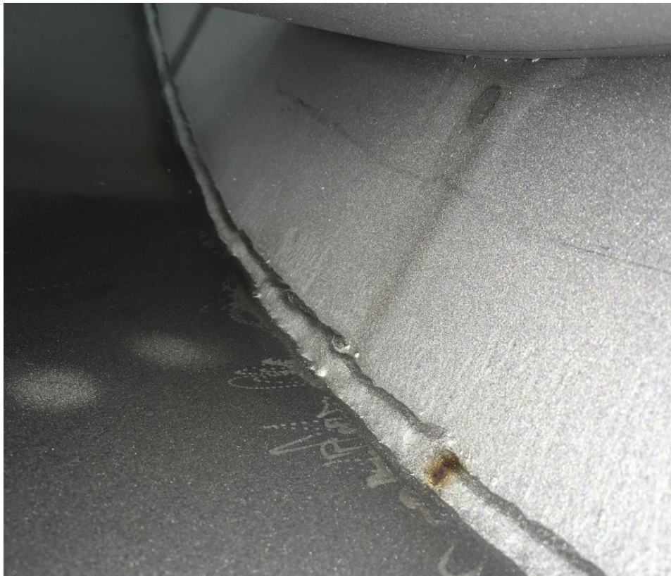
Slika 15: Pogreška oblika zavora zbog loše tehnike zavarivanja
