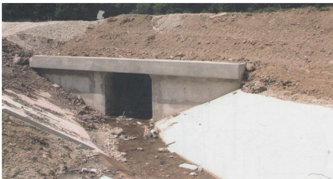
Slika 32. Pločasti betonski propust
