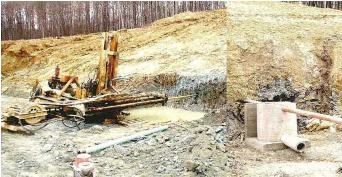
Slika 25. Bušenje horizontalne drenaže s detaljem spoja na odvodnju
