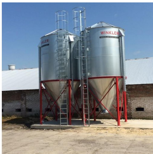
Slika 2. Silos za stočnu hranu
