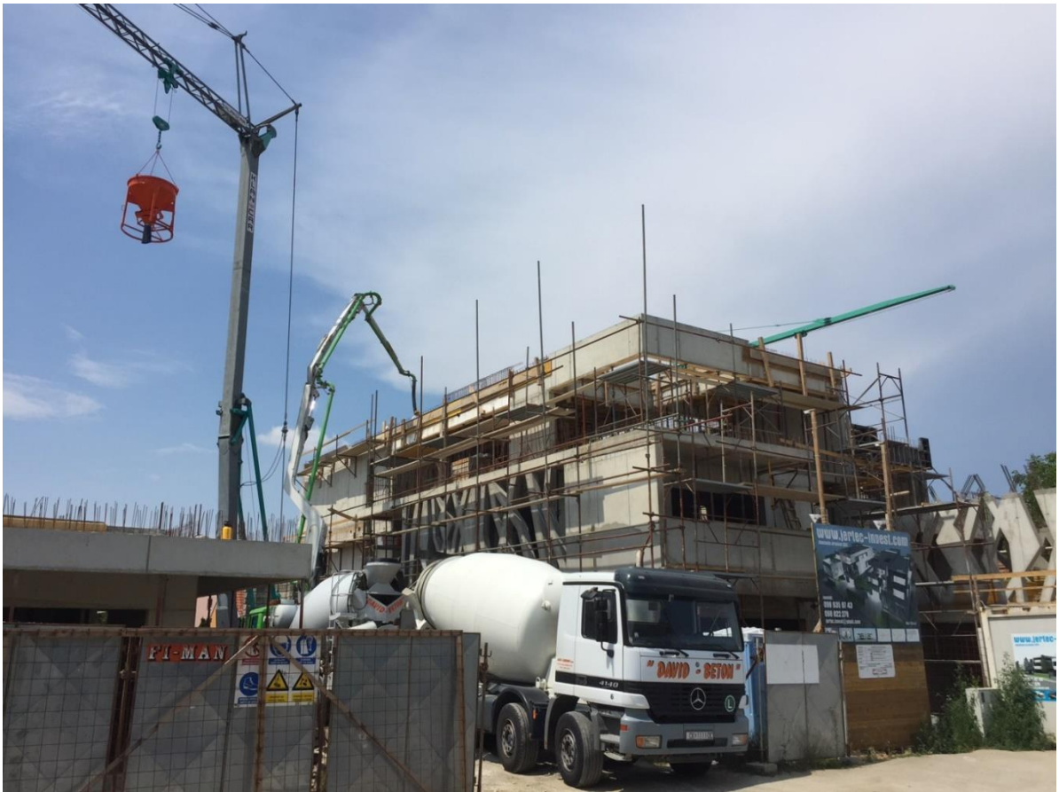
Slika br. 4. Ugrađivanje betonske mješavine (izvor: vlastiti)
