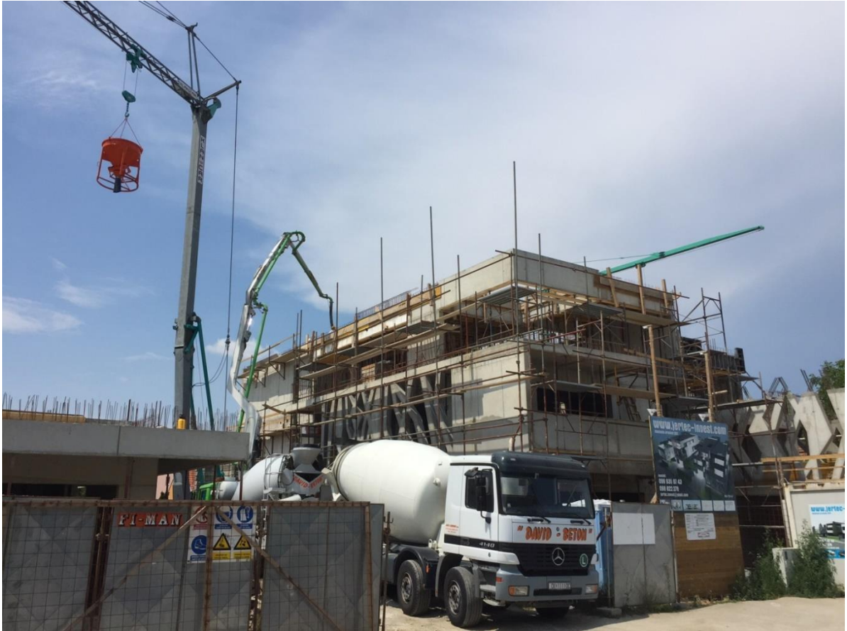
Slika br. 4. Ugrađivanje betonske mješavine (izvor: vlastiti)
