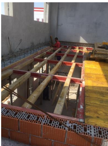
Slika 6. Postavljanje oplata za betoniranje ploče
