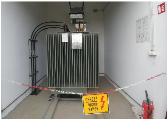
Slika 4.1. Energetski transformator proizvođača ABB jačine 2500kVA
