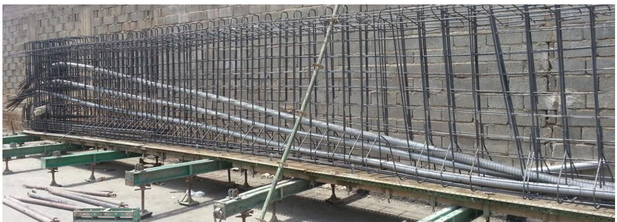
Slika 4.10 Postava kablova kod naknadnog prednaprezanja montažnog nosača velikog raspona
