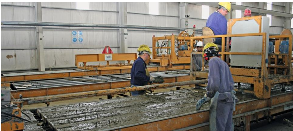
Slika 4.6 Poravnavanje betona nakon zalijevanja
