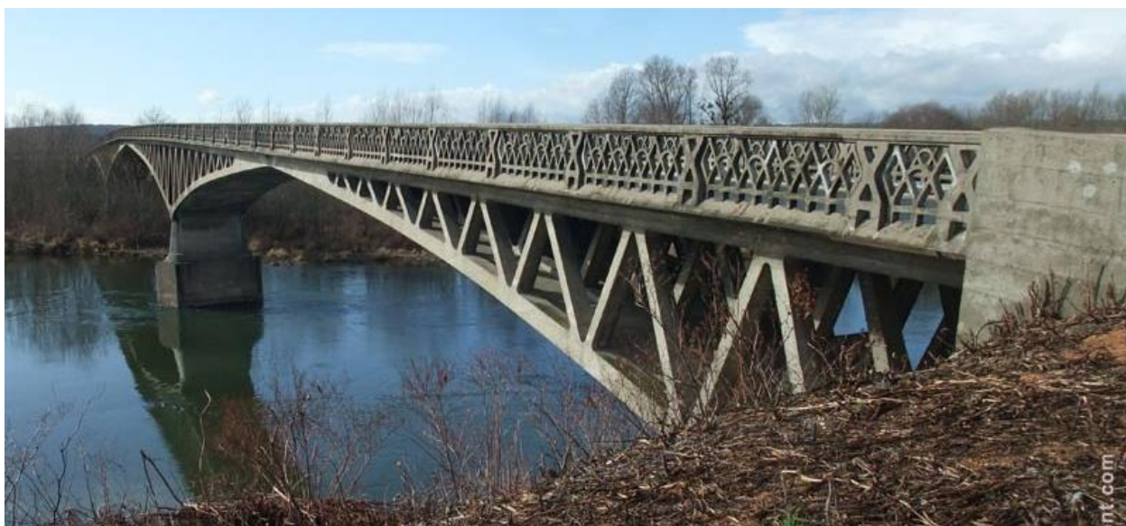
Slika 1.1 Most Pont de Boutiron na rijeci Allier
