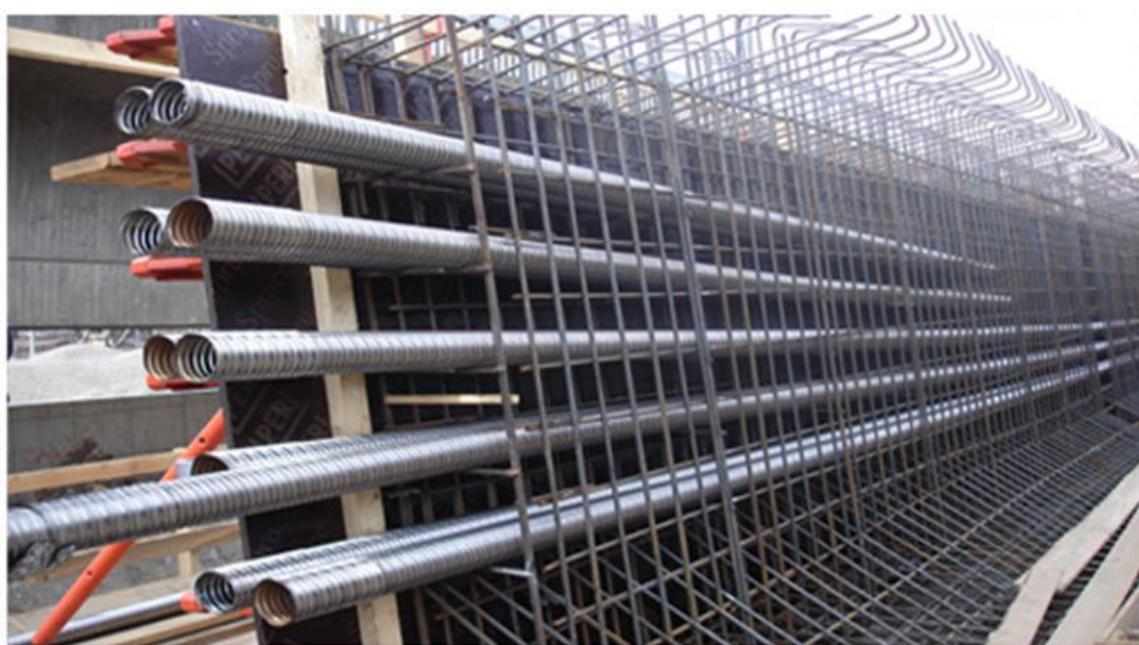
Slika 2.9 Profilirane zaštitne cijevi za jedan montažni mostovski nosač
