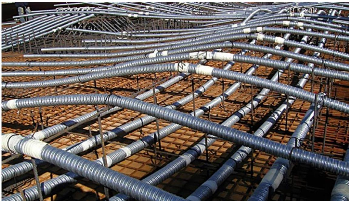
Slika 2.8 Brtvljene i položene zaštitne cijevi
