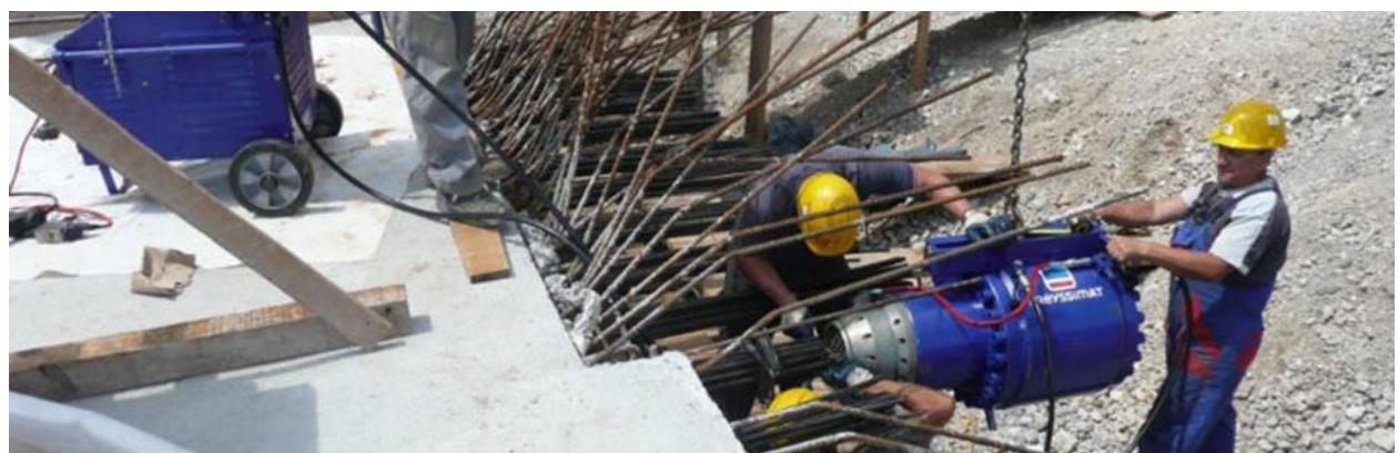
*Slika 3.2 Preša za naprezanje kabela*
