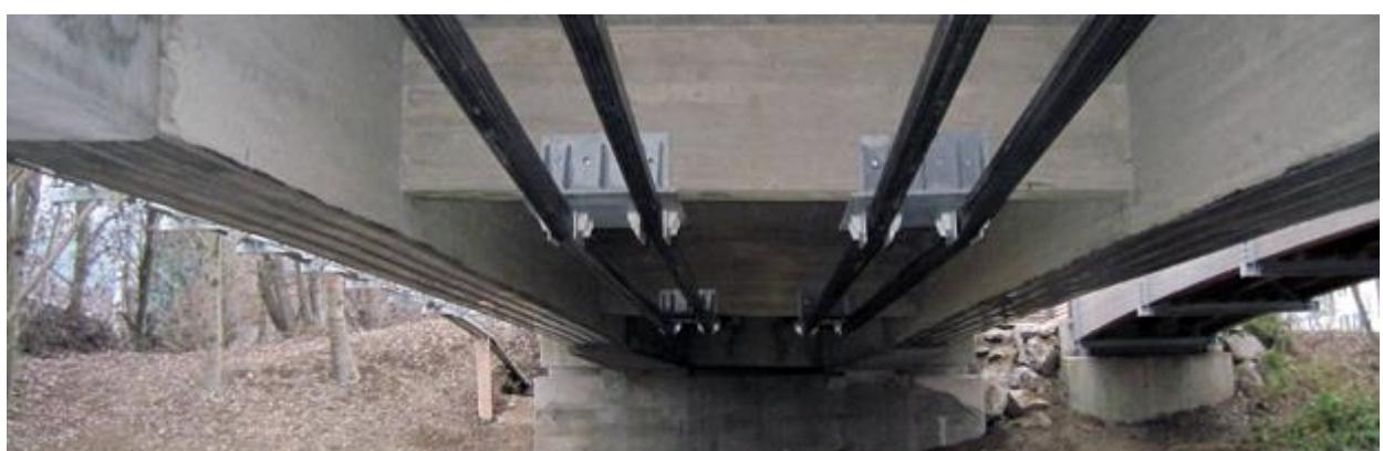
*Slika 2. Kabeli izvan betonskog presjeka*
