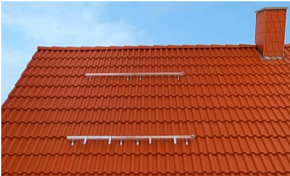
Slika 4.13. Prikaz pravilno montiranih nosača
