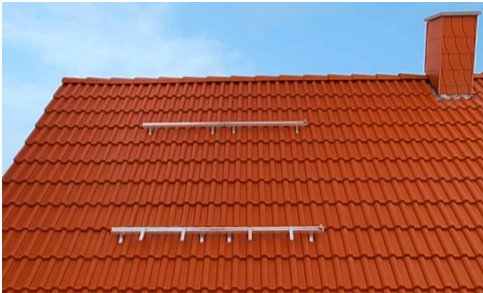
Slika 4.13. Prikaz pravilno montiranih nosača
