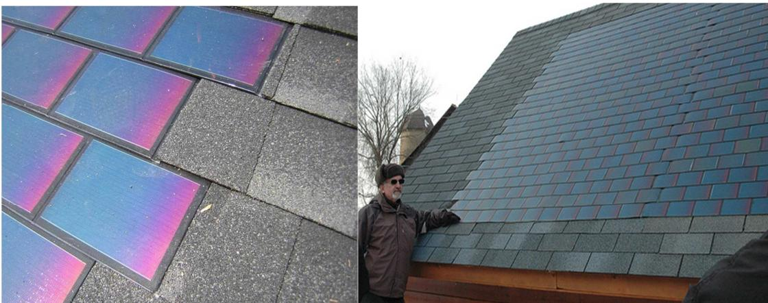
*Slika 3.7. Primjeri solarne šindre ugrađene u kombinaciji s klasičnom šindrom*
