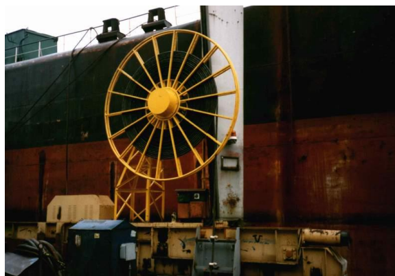
Slika 3.3: Kabelski bubanj za vanjsko napajanje [5]
