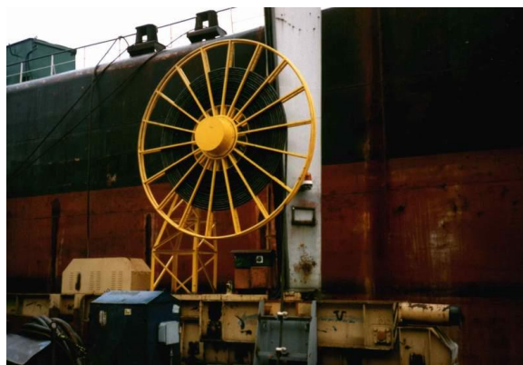
Slika 3.3: Kabelski bubanj za vanjsko napajanje [5]
