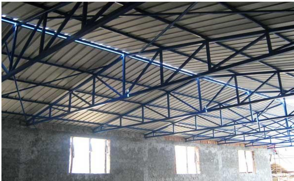
Slika 5.5. Metalna konstrukcija obojana pokrivnom lak bojom
