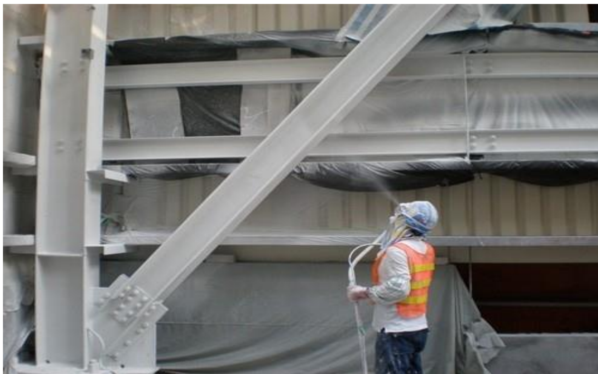
Slika 5.4. Prskanje metalne konstrukcije temeljnom bojom
