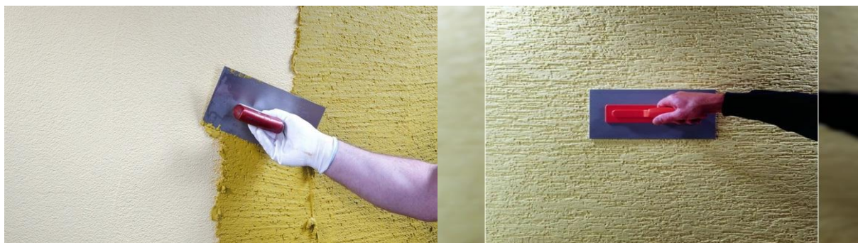
Slika 5.10. Nanošenje i obrada završno dekorativne žbuke
