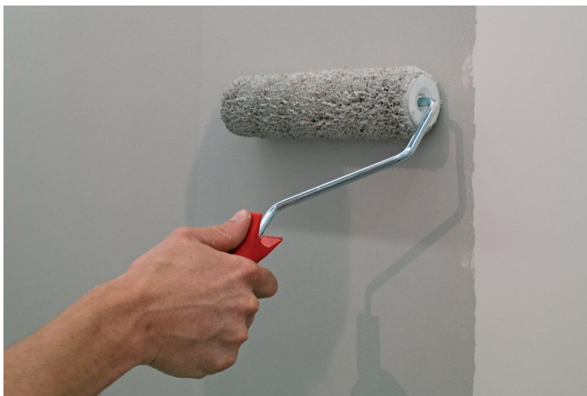
Slika 5.8. Nanošenje boje valjkom
