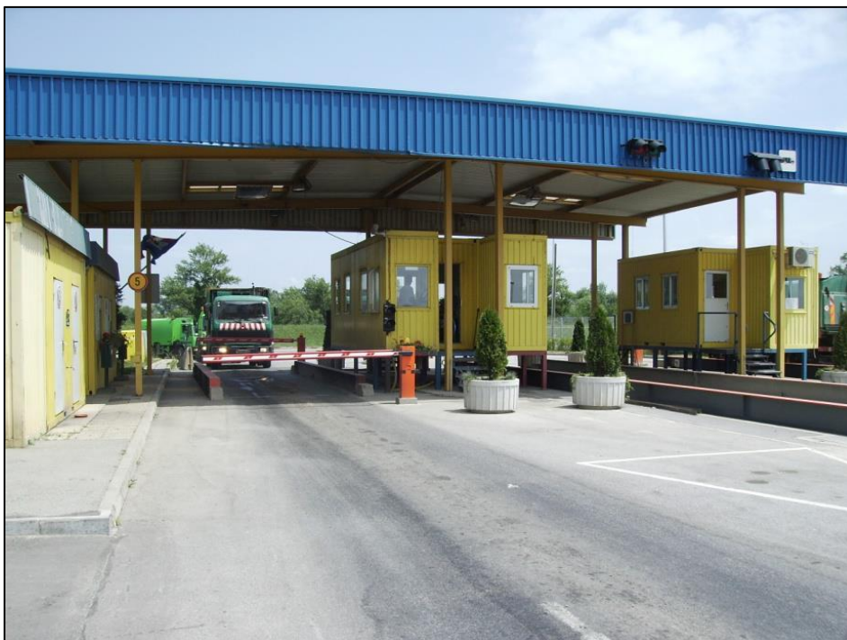
Slika 3.2. Ulaz kamiona na odlagalište otpada
