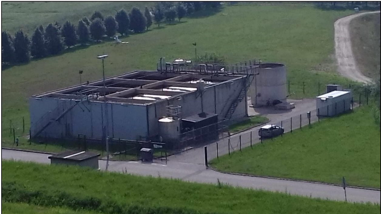
Slika 9.3. Pročistač otpadnih voda sa spremnicima
