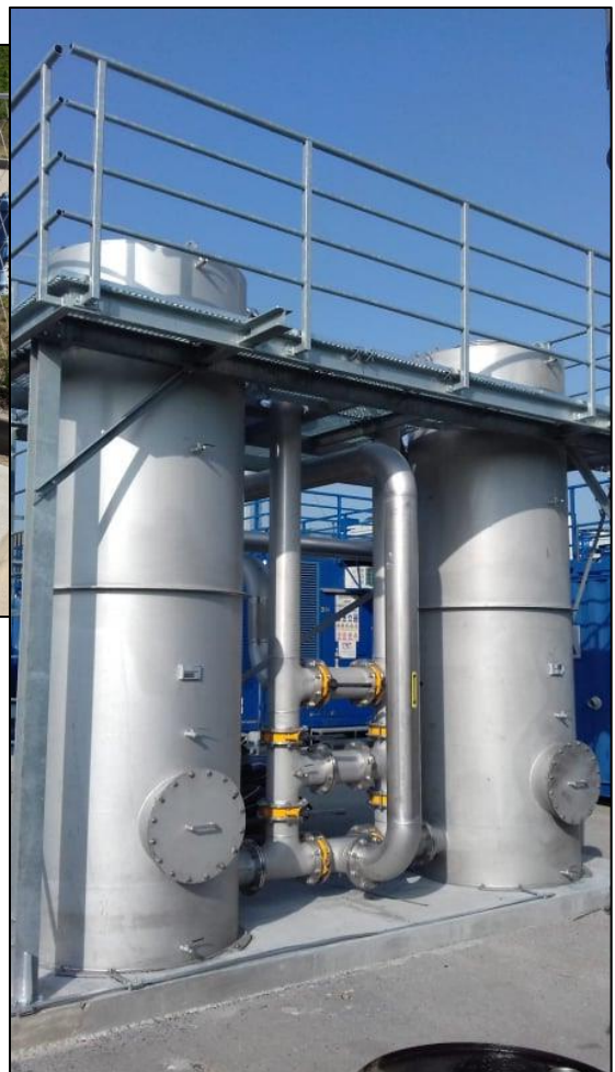
Slika 7.4. Jedinica s aktivnim ugljenom
