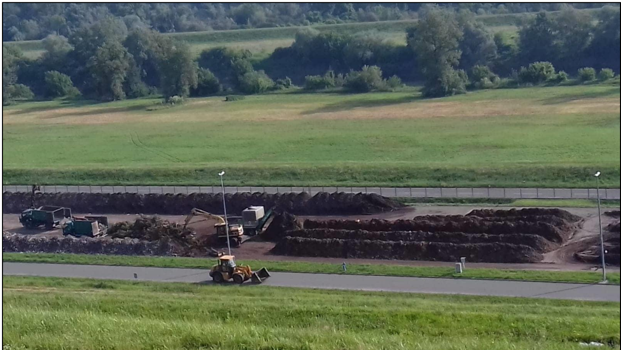
Slika 10.1. Kompostana na odlagalištu otpada
