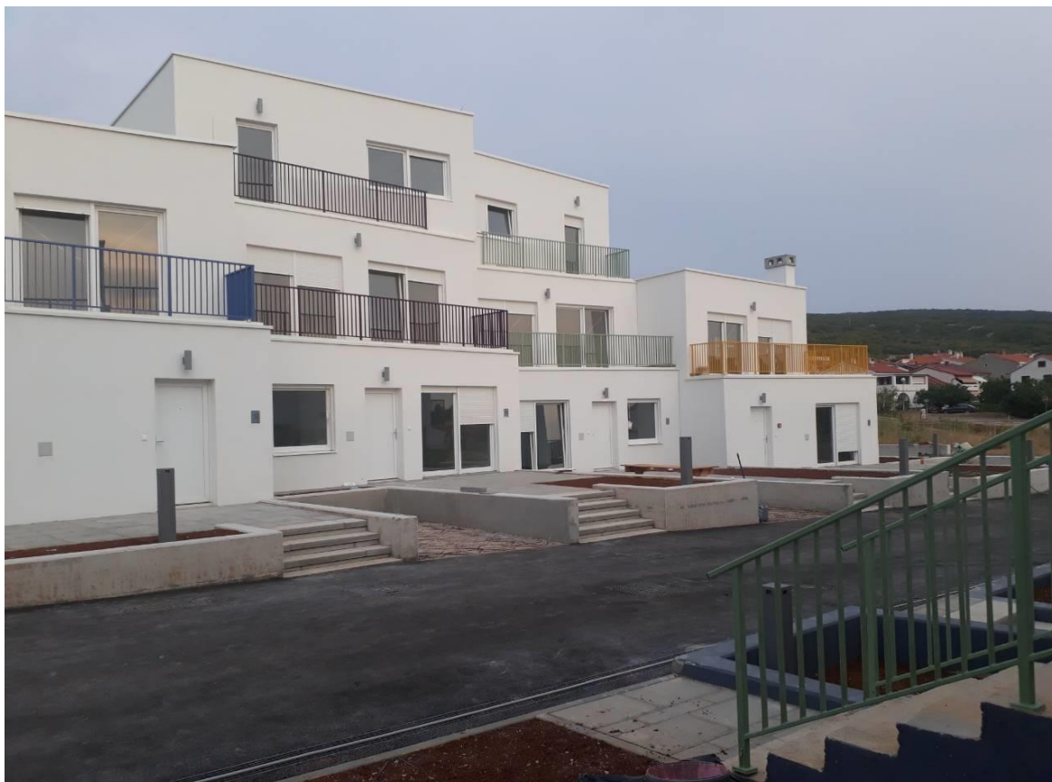
Slika 1.2. Pogled na pročelje stambenog niza B
