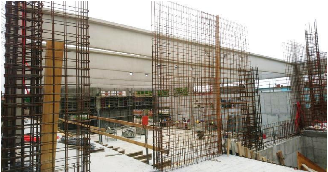
Slika 3.3 Armaturni koševi zidova ( Izvor: autor )
