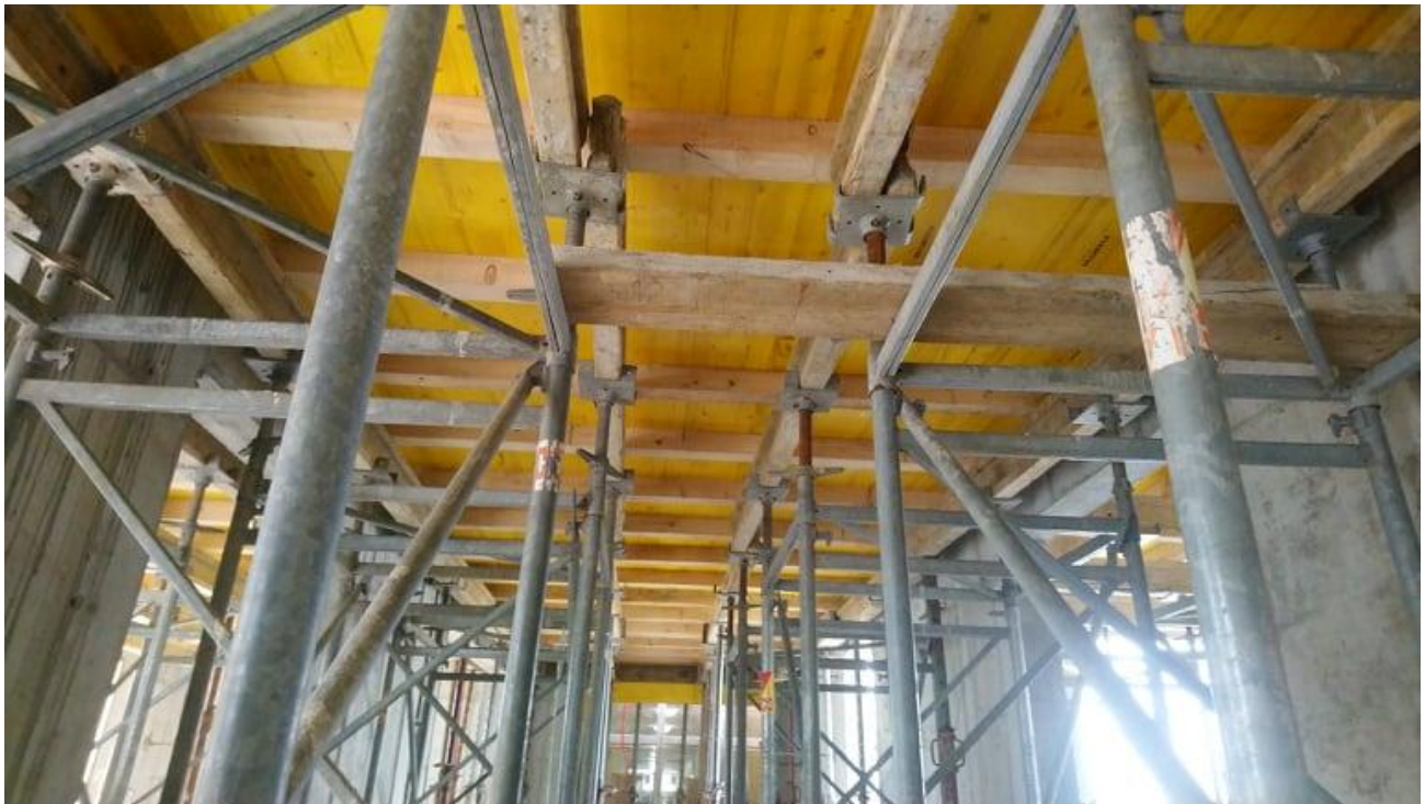
Slika 3.5 Prikaz klasične drvene oplata ( Izvor: autor )
