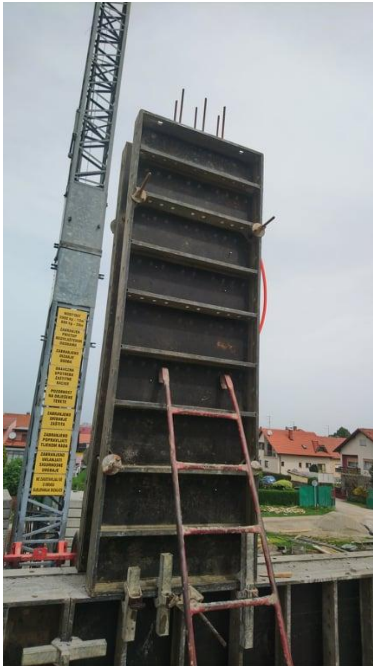
Slika 3.6 Zidna (kranska) oplata (Izvor: autor)
