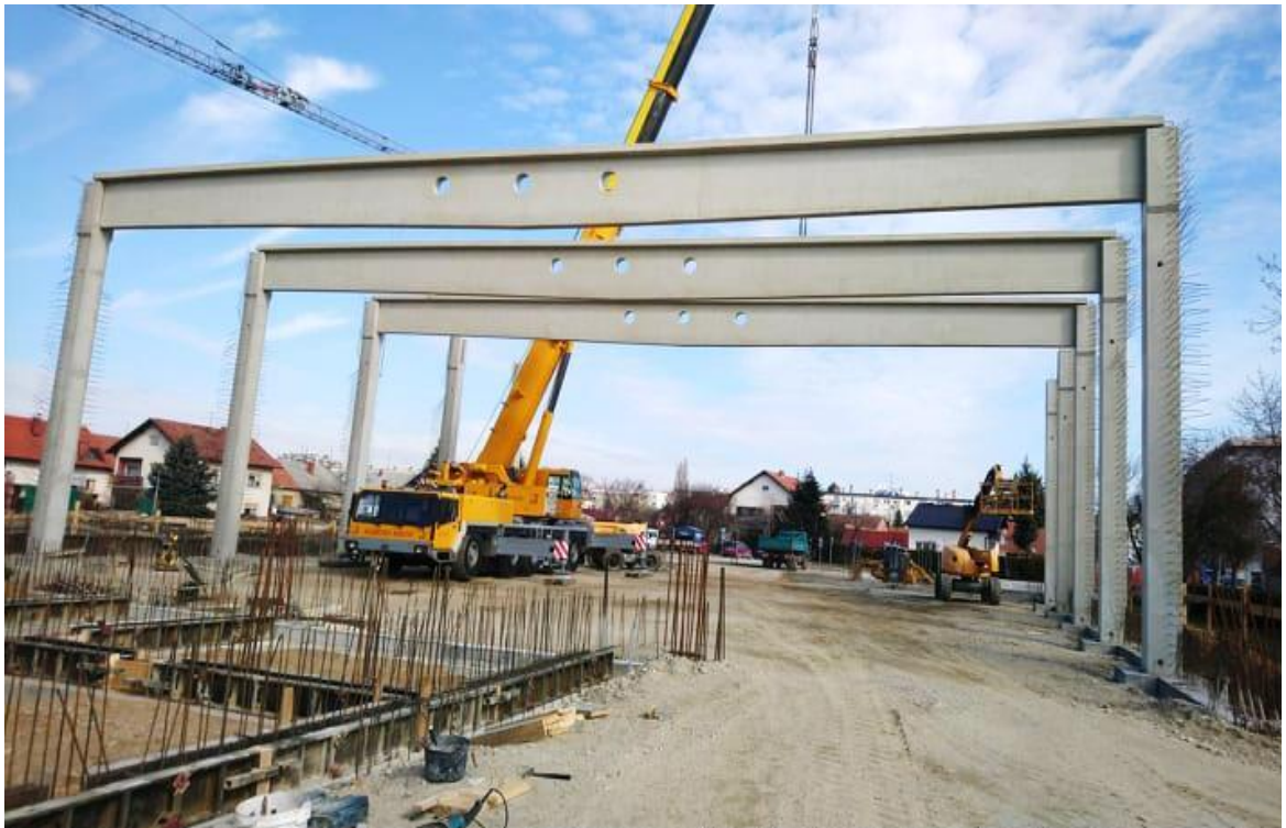
Slika 3.4 Prikaz montažnih betonskih greda ( Izvor: autor )
