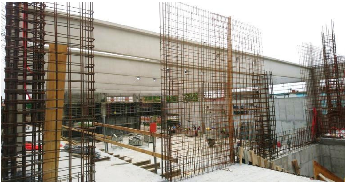
Slika 3.3 Armaturni koševi zidova ( Izvor: autor )
