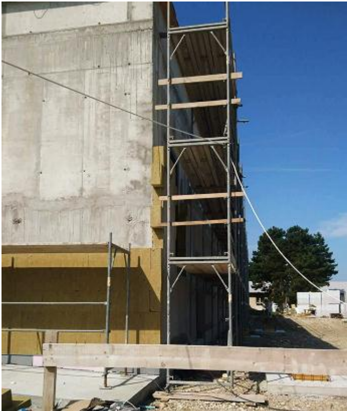
Slika 3.8 Termoizolaterski radovi ( Izvor: autor )
