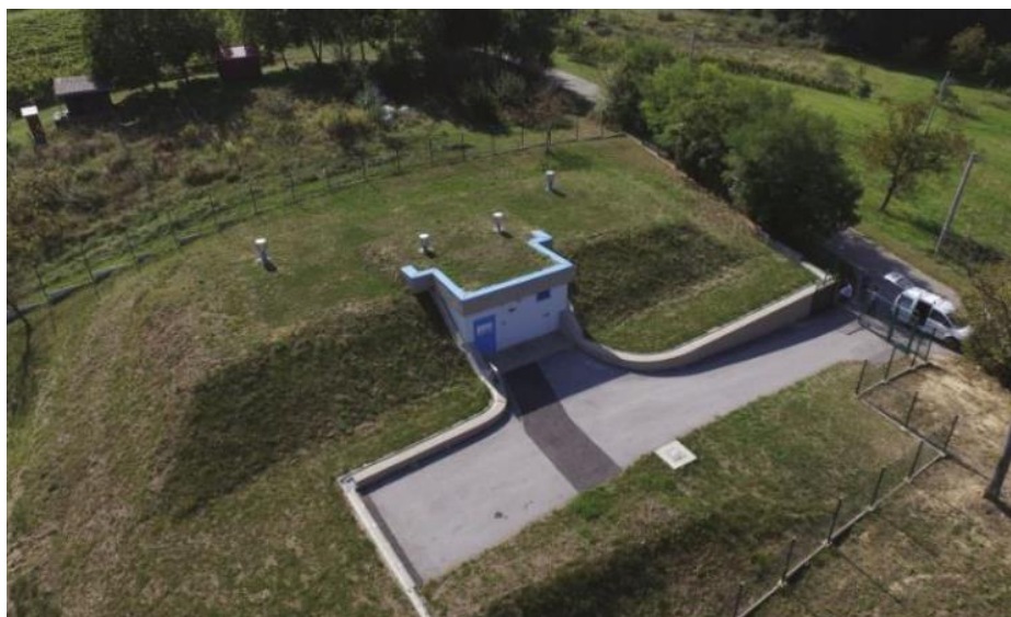
Slika 1.2 Vodosprema Železna gora [2]
