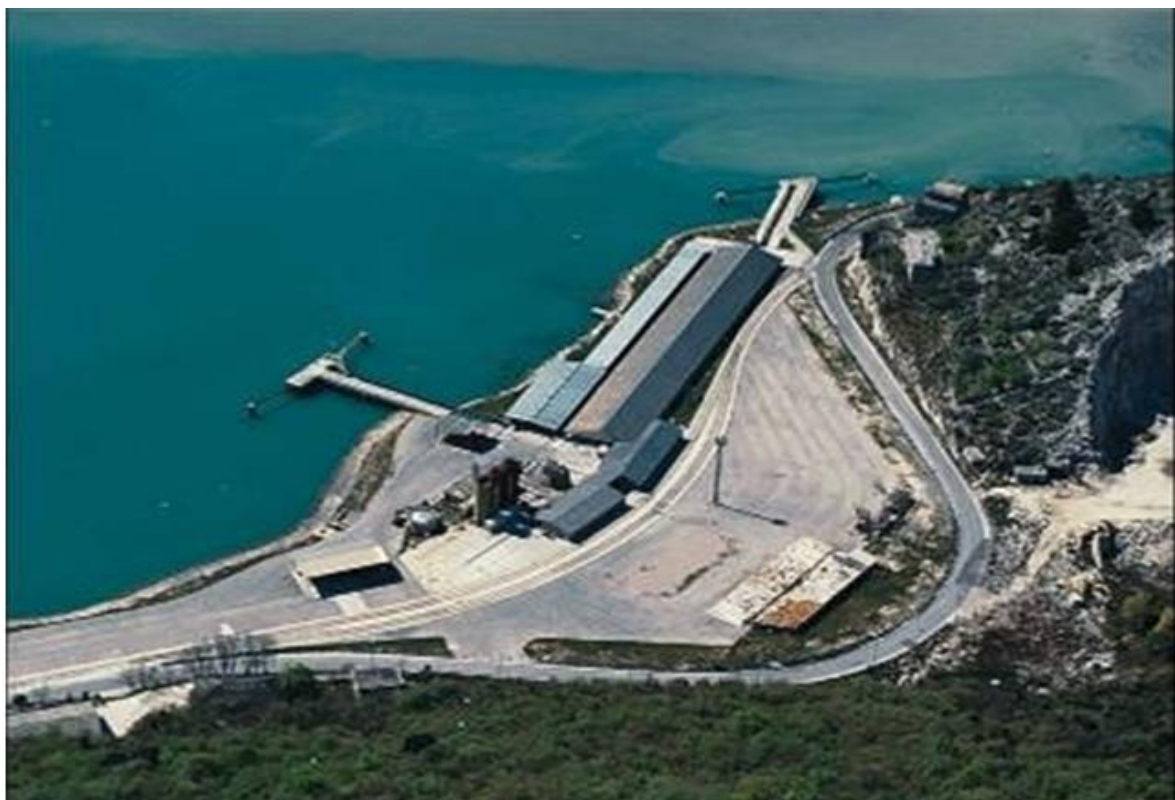
Slika 5.17. Terminal Bršica iz zraka (Izvor: https://lukarijeka.hr/ )
