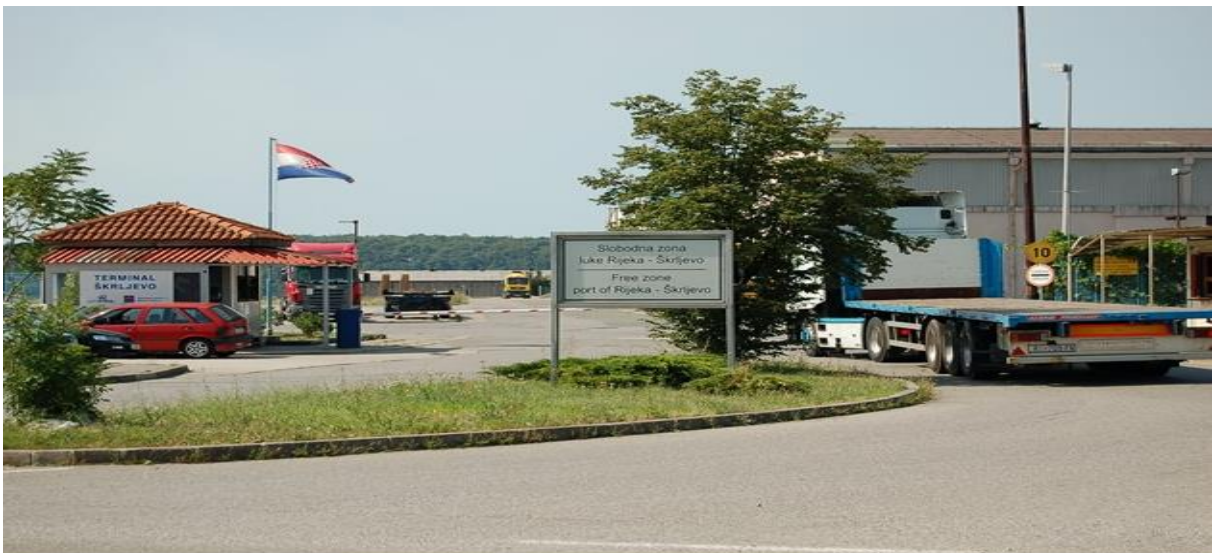
Slika 5.13. Terminal Škrljevo – ulaz (Izvor: https://lukarijeka.hr/ )
