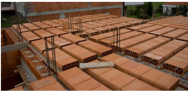
Slika 2.18 Porotherm strop (slika lijevo) i „Bijeli strop“ (slika desno)
