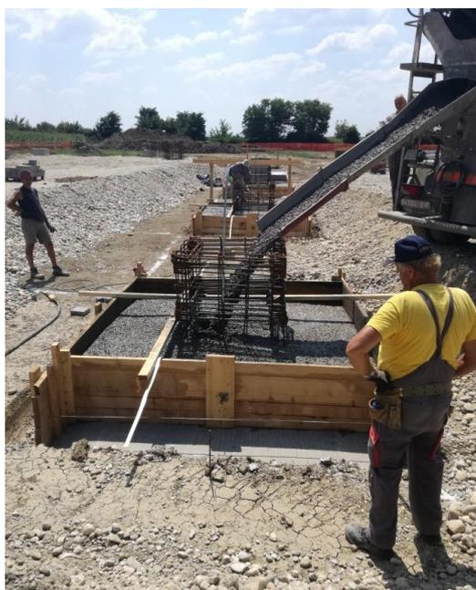
*Slika 4.8. Betoniranje temeljne stope*
