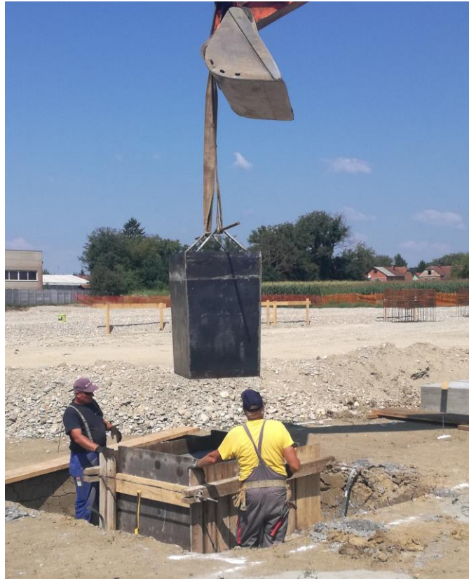
Slika 4.6. Čelična oplata temeljnih čašica
