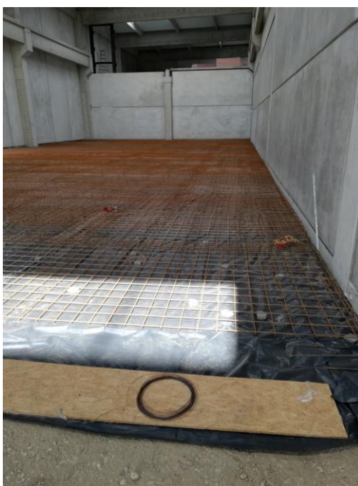
Slika 4.14. Hidroizolacija podne AB ploče PE folijom
