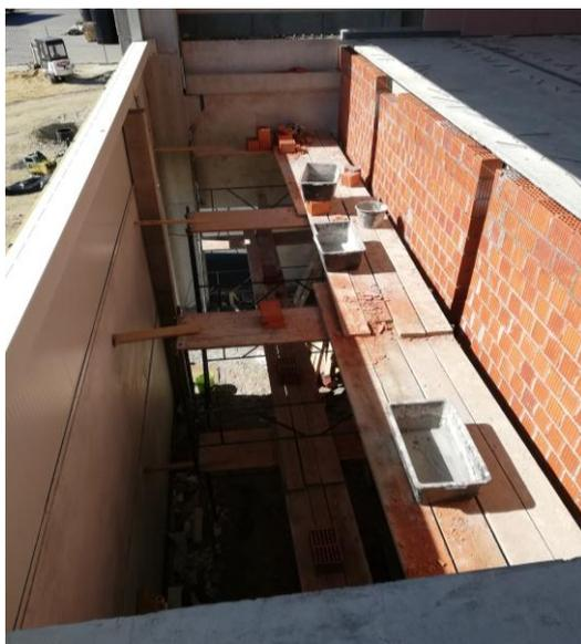
*Slika 4.13. Unutarnji pregradni zidovi izvedeni šupljom opekom*
