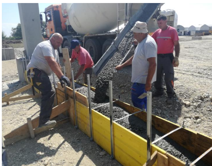
Slika 4.7. Betoniranje temeljnih traka
