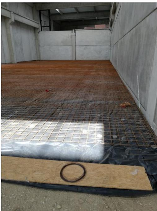
*Slika 4.14. Hidroizolacija podne AB ploče PE folijom*
