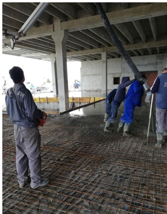
Slika 4.10. Betoniranje podne ploče utovarnih rampi
