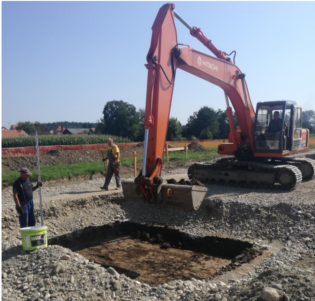
Slika 4.2. Iskop zemljanog materijala za izvođenje temeljne stope
