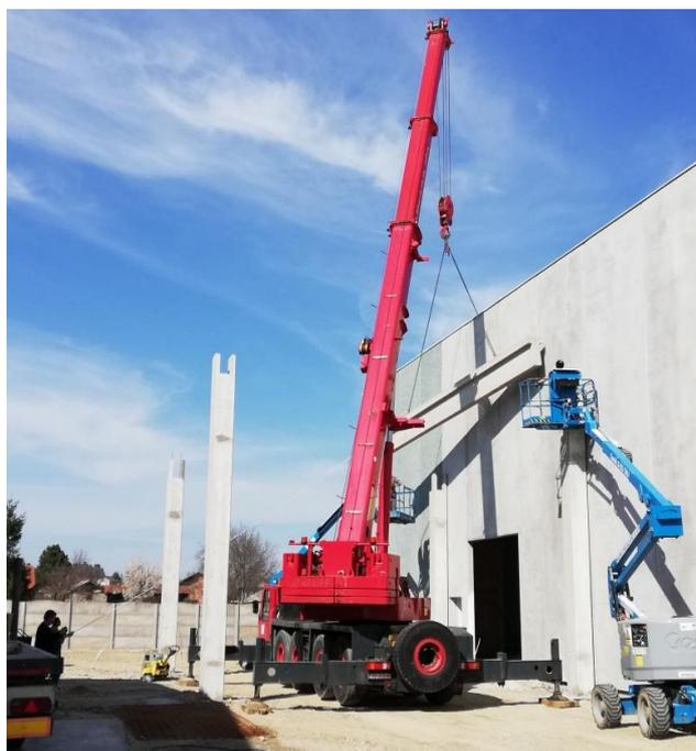
*Slika 4.12. Montaža nosača nadstrešnice autodizalicom*
