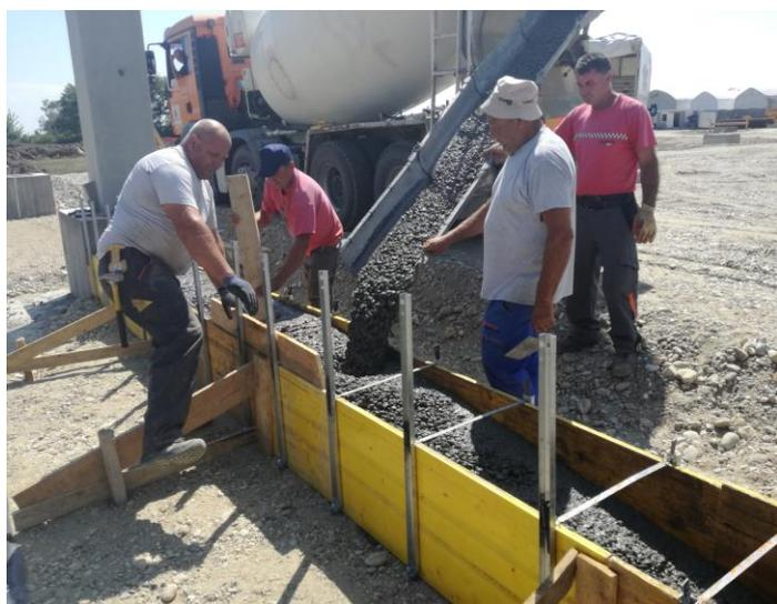
*Slika 4.7. Betoniranje temeljnih traka*
