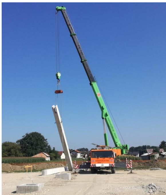
*Slika 4.11. Montaža AB stupa autodizalicom*
