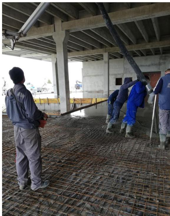
*Slika 4.10. Betoniranje podne ploče utovarnih rampi*
