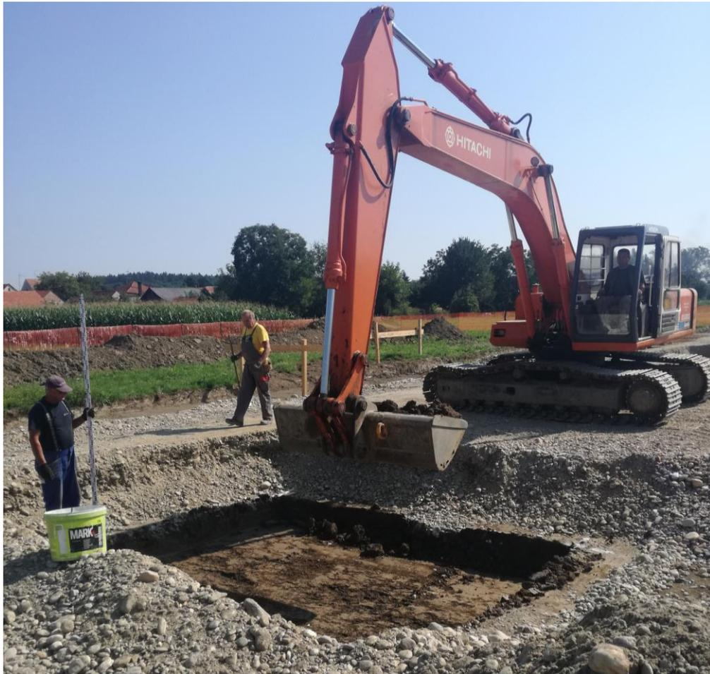
*Slika 4.2. Iskop zemljanog materijala za izvođenje temeljne stope*
