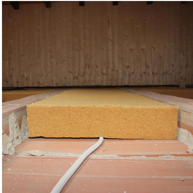
Slika 4.16 Podna izolacija od drvenih vlakana
