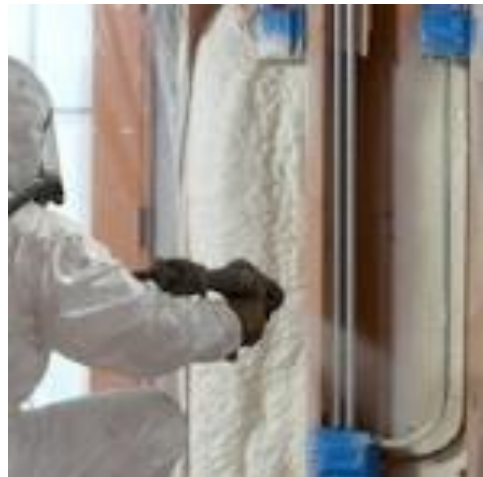
Slika 4.9 Metoda prskanja poliuretanske pjene pištoljem
