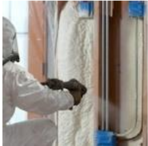
Slika 4.9 Metoda prskanja poliuretanske pjene pištoljem
