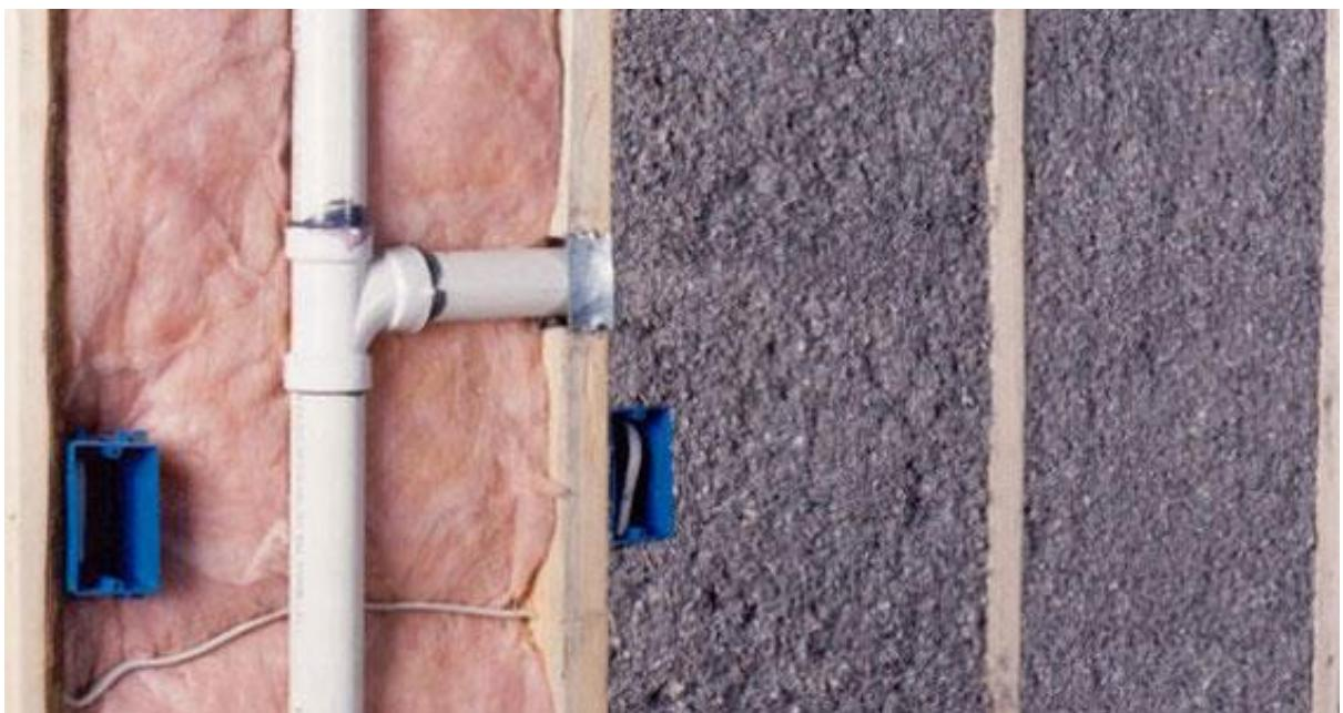
*Slika 4.14 Usporedba ispunjenosti konstrukcije između mineralne vune i celuloze*
