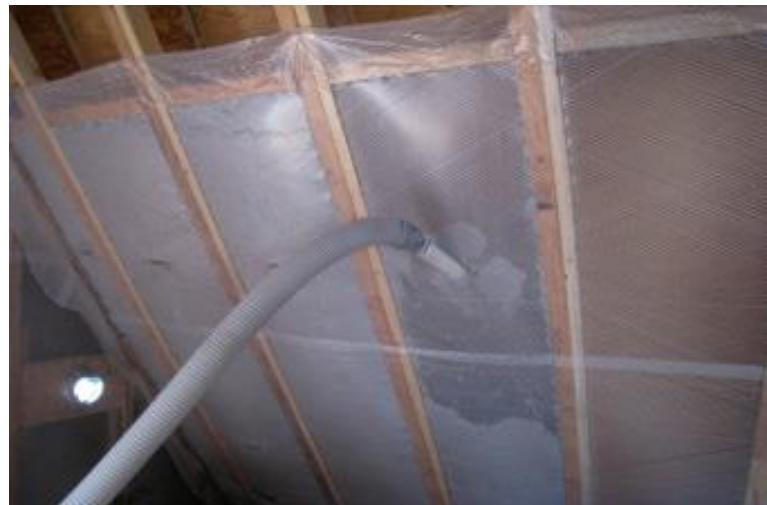
*Slika 4.12 Ugradnje celuloze metodom upuhivanja*
