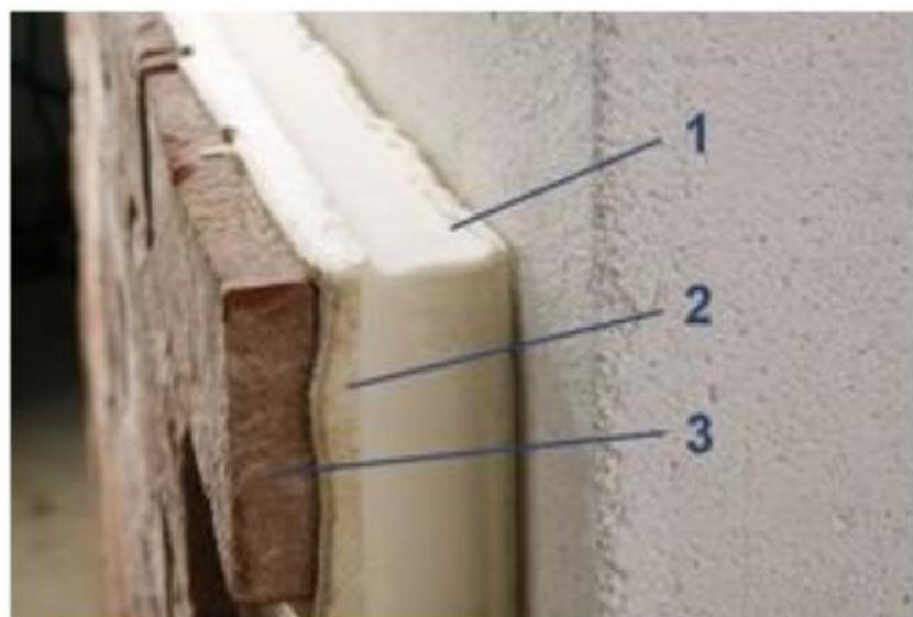
*Slika 4.10 Panel s izolacijom od poliuretanske pjene (1-poliuretanski izolacijski sloj,
