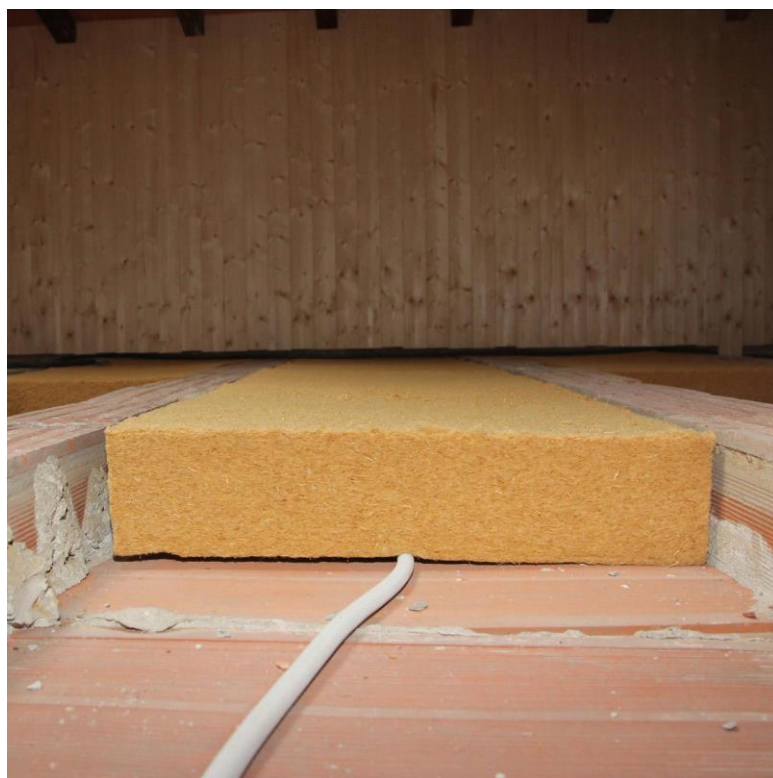
Slika 4.16 Podna izolacija od drvenih vlakana
