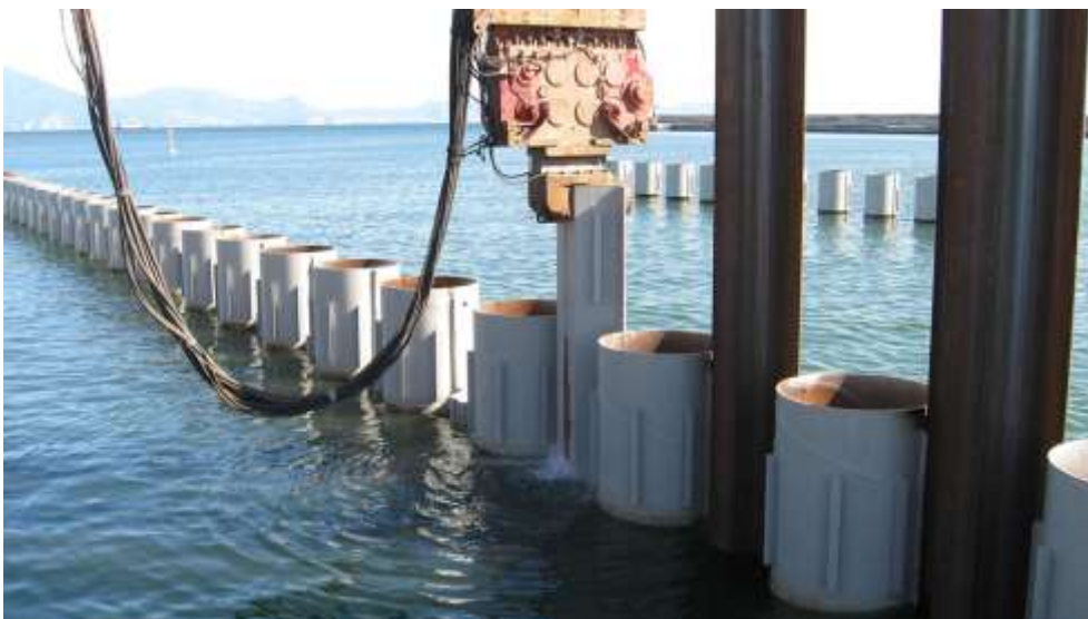
Slika 2.9. Čelijasti zagat.
