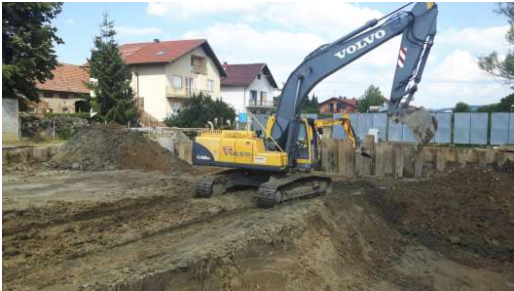
Slika 5.6. Iskop u građevinskoj jami.
