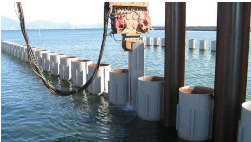
Slika 2.9. Čelijasti zagat.
