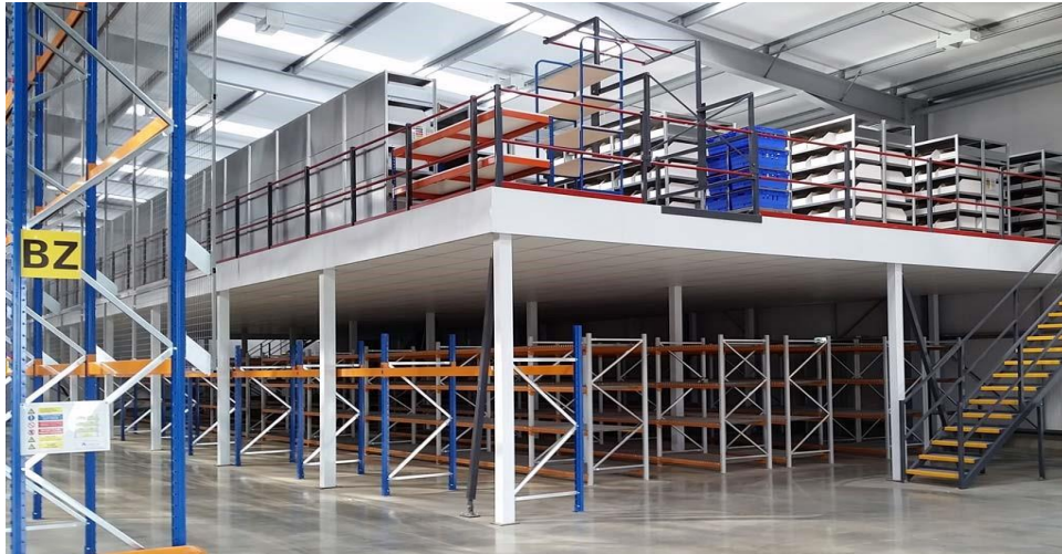
Slika 3. Prikaz katnog skladišta
