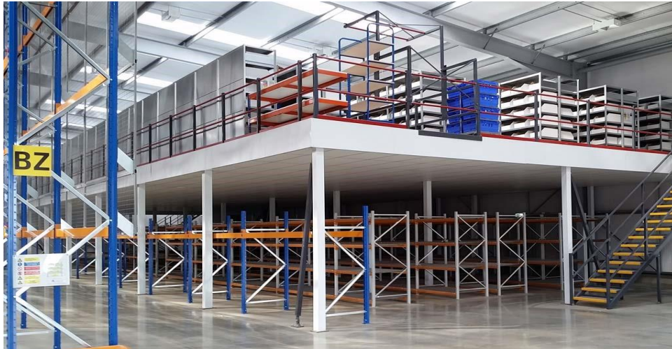
Slika 3. Prikaz katnog skladišta
