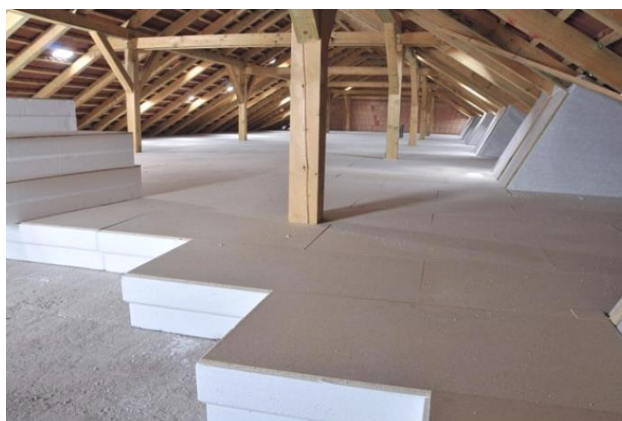
Slika 3.11. Postavljanje EPS-a u potkrovlje
