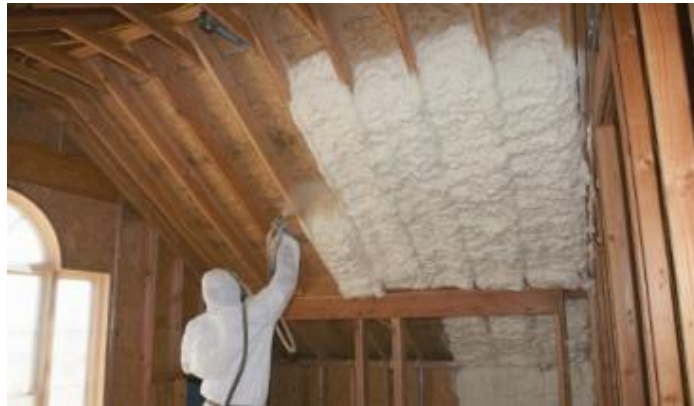
Slika 3.12. Nanošenje poliuretanske pjene na krov
