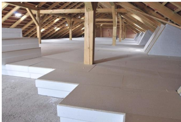
Slika 3.11. Postavljanje EPS-a u potkrovlje
