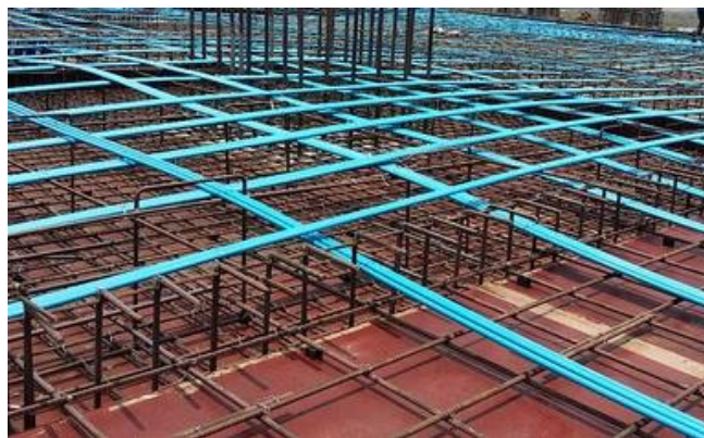
Slika 2.4. Unbonded tehnologija
