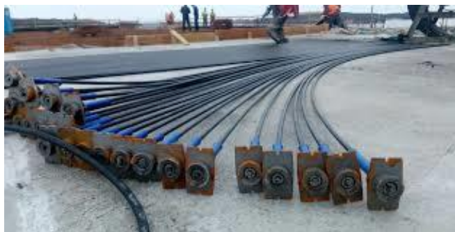
Slike 2.7. i 2.8. Unbonded kabeli sa sidrenim pločama
