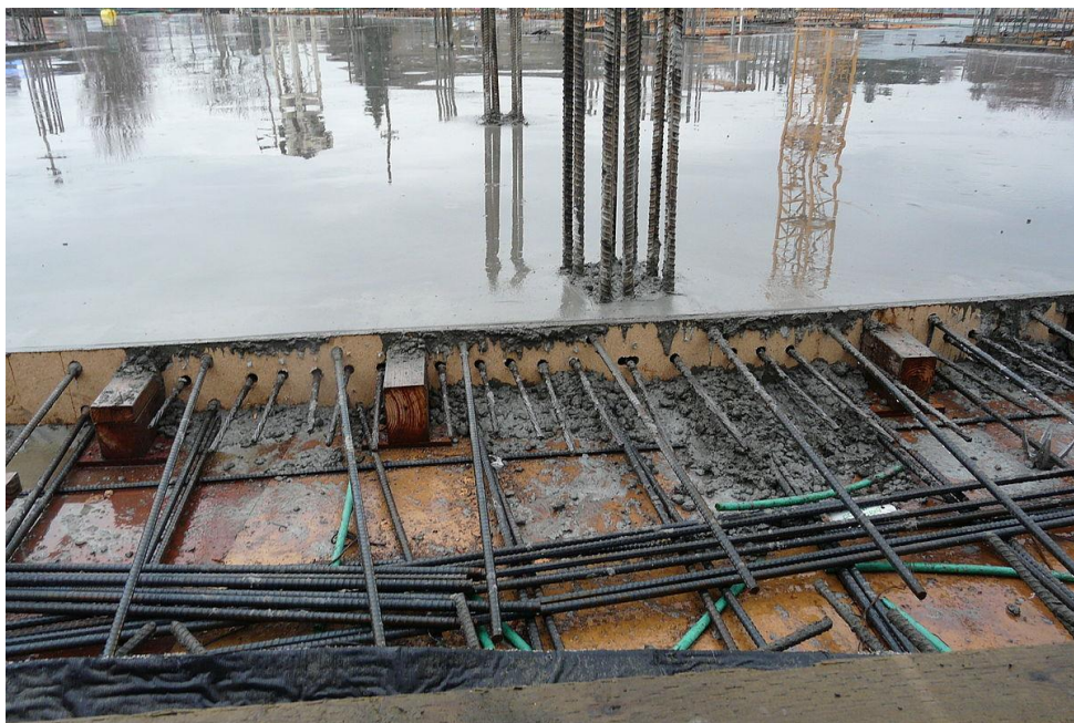
Slika 2.11. Aktivna usidrenja nakon betoniranja
