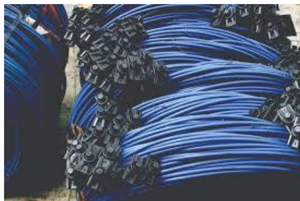
Slika 2.6. Unbonded kabeli u kolotovima
