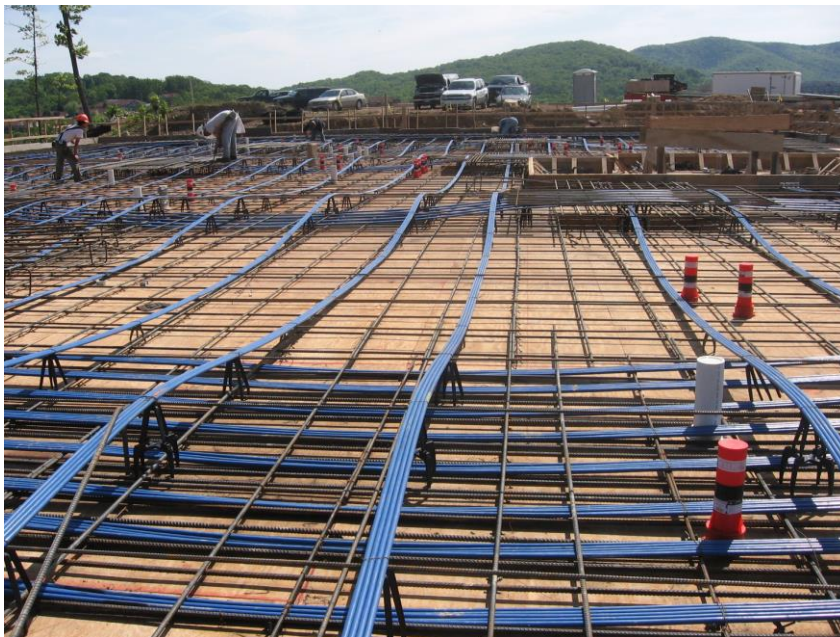
Slika 2.2. Postavljeni kabeli na stropnoj ploči u izradi
