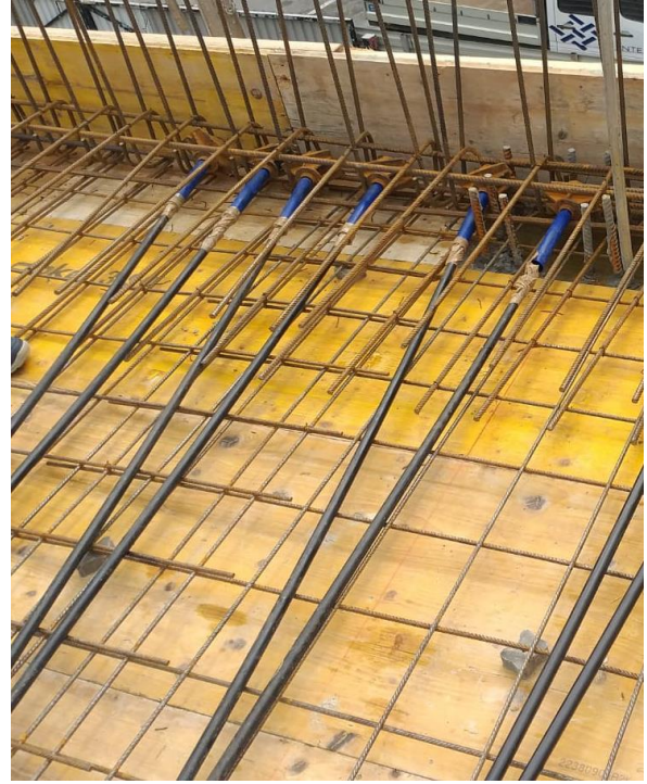
Slika 2.10. Pasivna usidrenja
