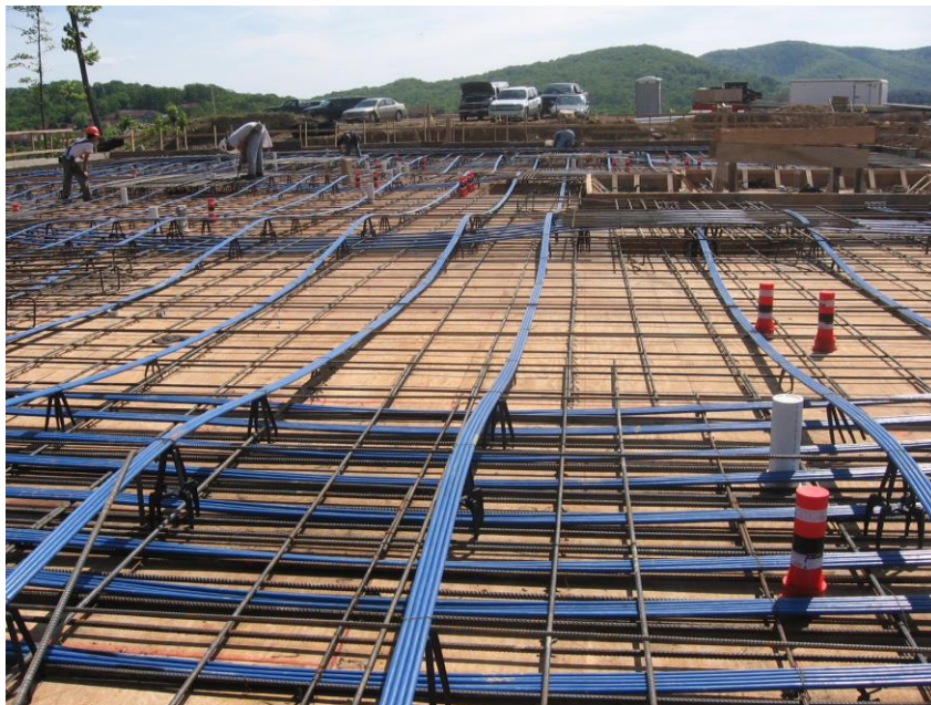
Slika 2.2. Postavljeni kabeli na stropnoj ploči u izradi
