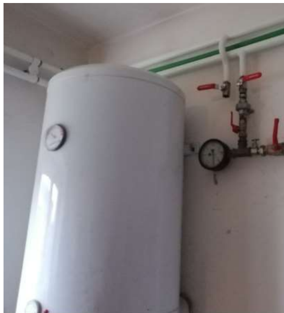
Slika 3.4.2 Postojeći spremnik za pripremu PTV-a
