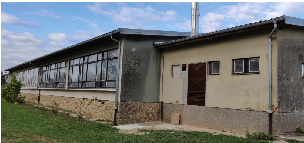
Slika 3.1 Ulazno(jugoistočno) pročelje zgrade i kotlovnica
