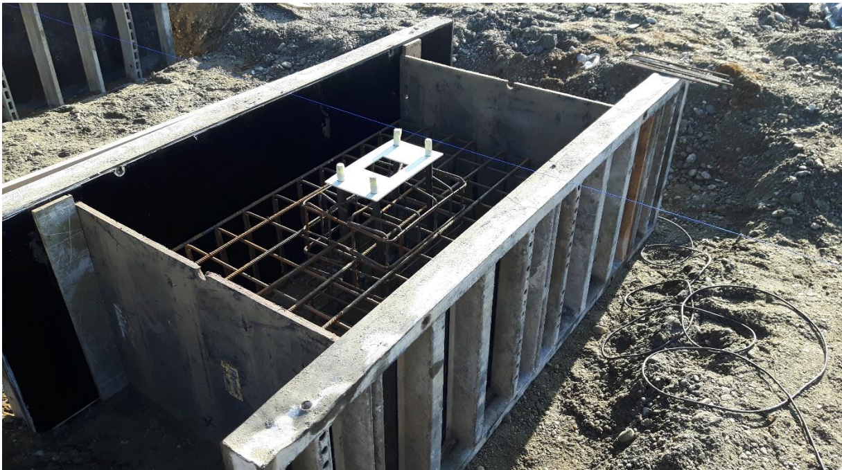
Slika 9. Oplata za temeljne stope
