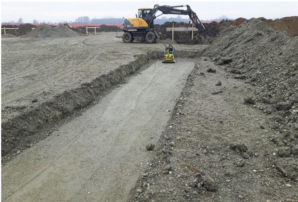
Slika 3. Strojni iskop jame
