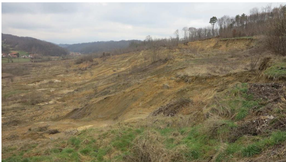
Slika 1.2. Pogled duž glinokopa [1]
