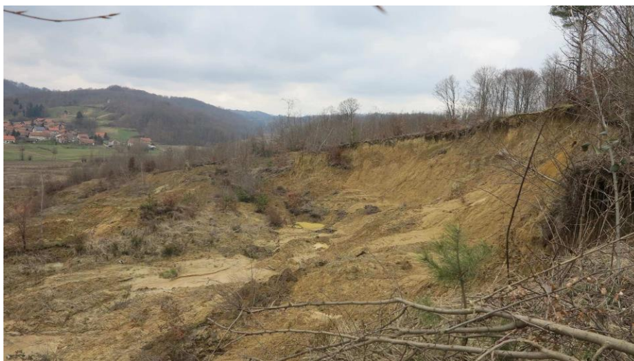
Slika 4.3. Pogled prema najvišoj koti čela glinokopa [1]
