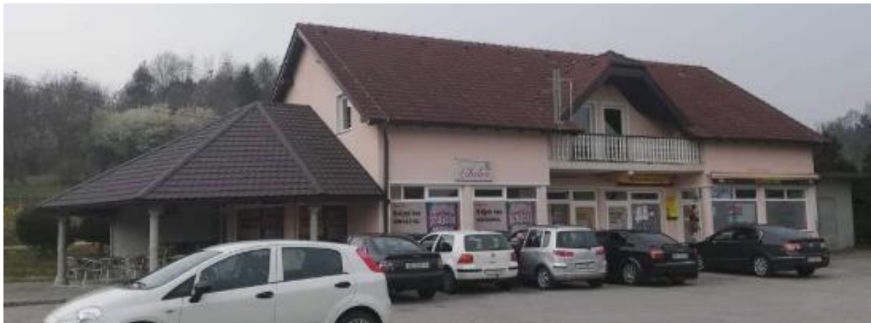
Slika 1 Sjeveroistočno i Jugoistočno pročelje
