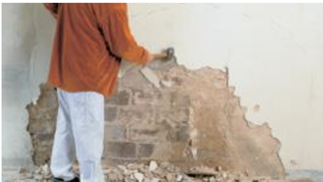
Slika 3.4.2.. Skidanje stare boje sa zida
