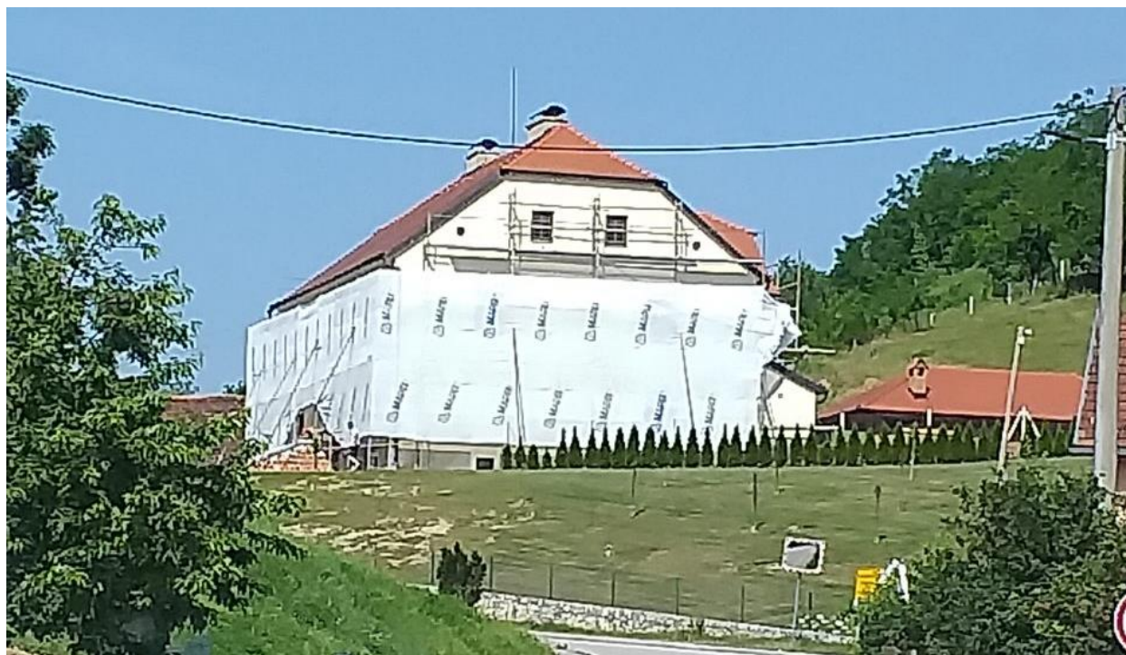
Slika 3.3.1. postavljena skela na župnom dvoru
