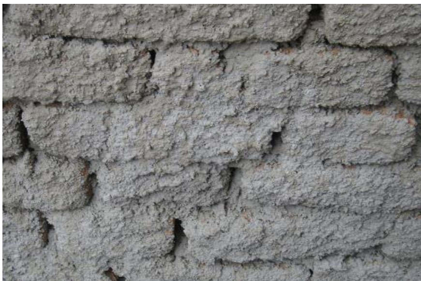
Slika 3.4.1. Nanošenje šprica
