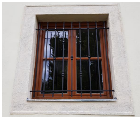
Slika 3.7.4. Restaurirani kameni prozorski okvir
