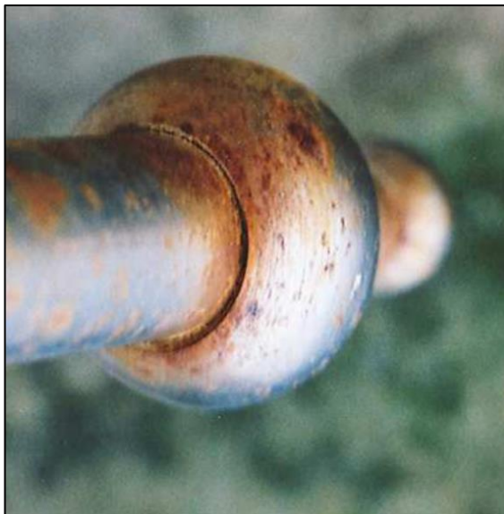
Slika 19: Korozija u procjepu [20]
