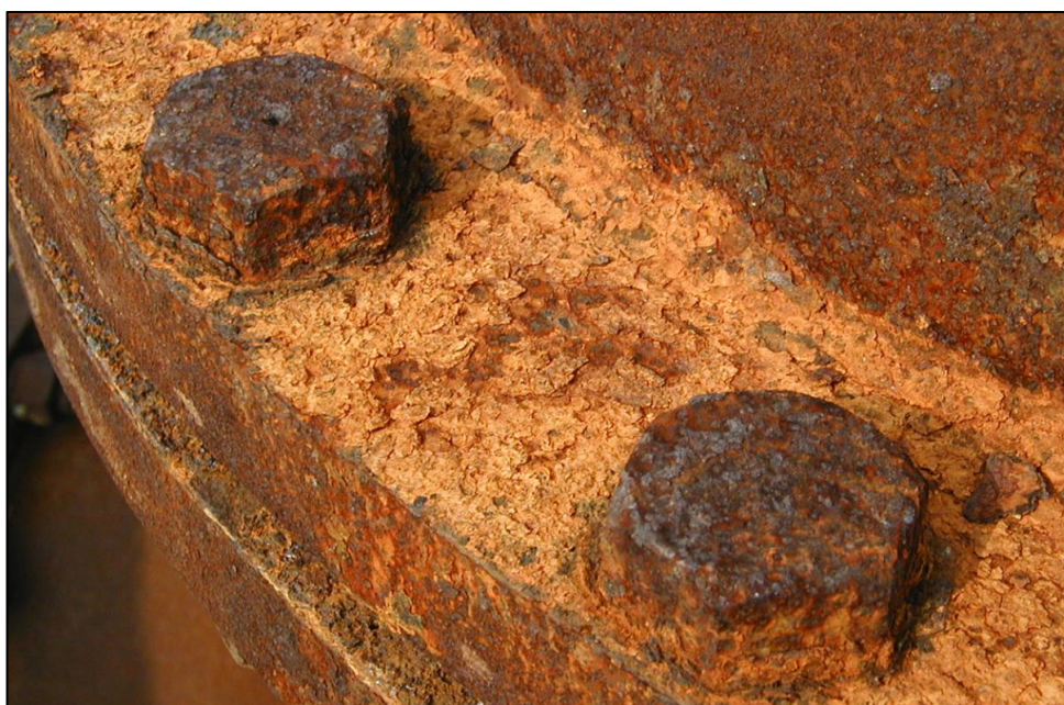
Slika 12: Opća korozija [17]
