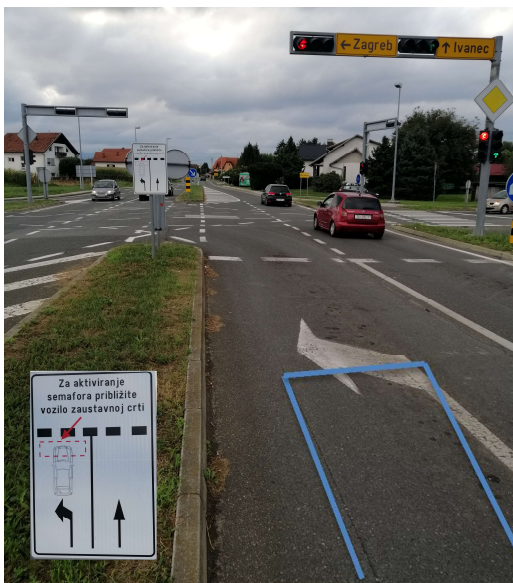
Slika 37. Prikaz primjera induktivne petlje na Varaždinskoj istočnoj zaobilaznici (Izvor: Fotografija autora)
