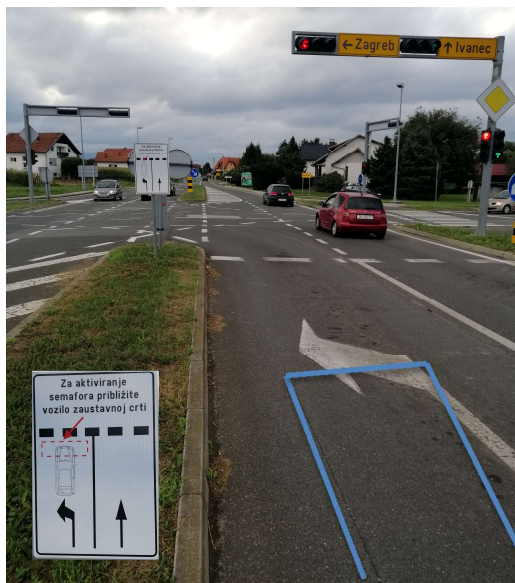
Slika 37. Prikaz primjera induktivne petlje na Varaždinskoj istočnoj zaobilaznici (Izvor: Fotografija autora)
