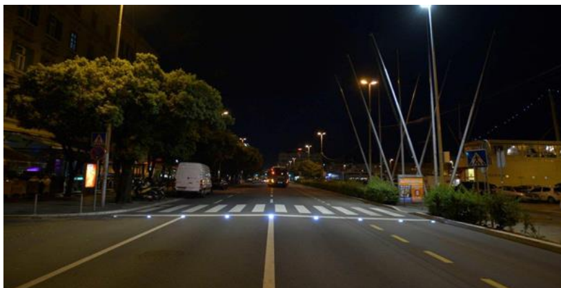
Slika 7. Obilježavanje pješačkog prijelaza LED prometnim svjetlima
