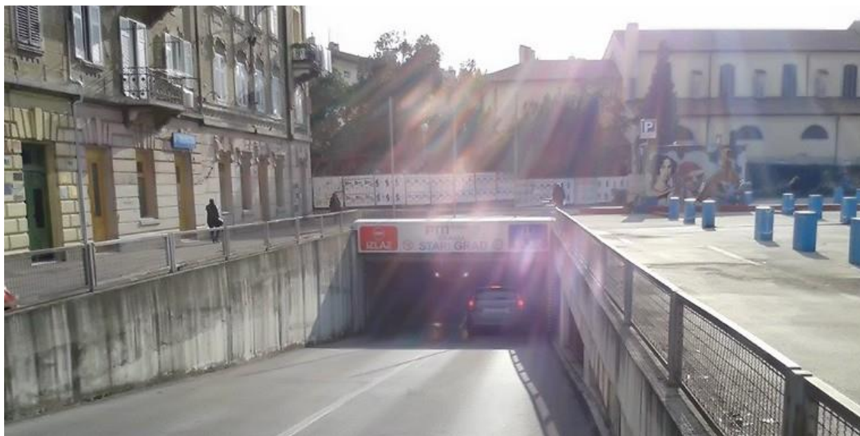
Fotografija 19: Podzemna garaža je „Stari grad“ u Rijeci
