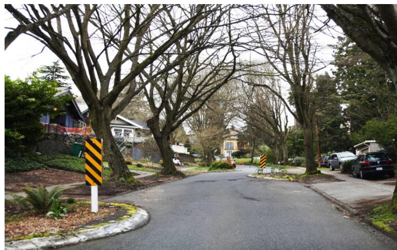
Slika 7.1.3. Primjer oštrog zavoja kao mjera za usporavanje prometa (izvor: https://streetsillustrated.seattle.gov/design-standards/trafficcalming/ ; 18.09.2019.)
