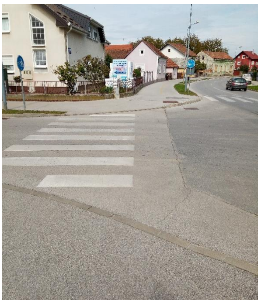
Slika 4.8 Prekid biciklističke staze u Starogradskoj ulici na križanju s Ulicom I. Mažuranića
