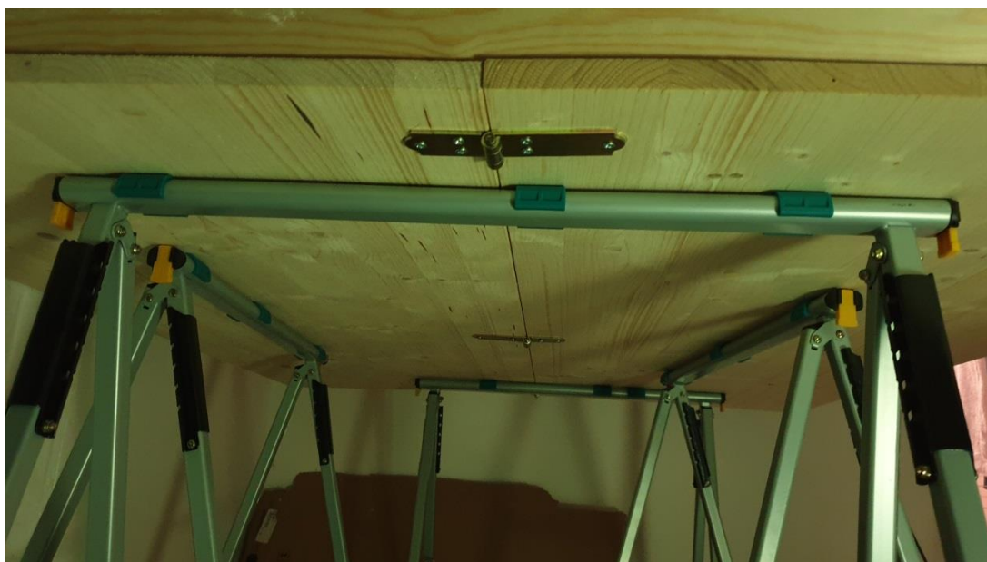
Slika 6.3.2. donji dio scenografije, s vidljivim nogarima i preklopnim metalnim spojnicama
