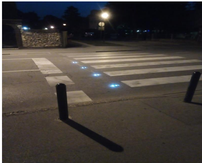
Slika 15. LED diode za dodatno isticanje pješačkog prijelaza
