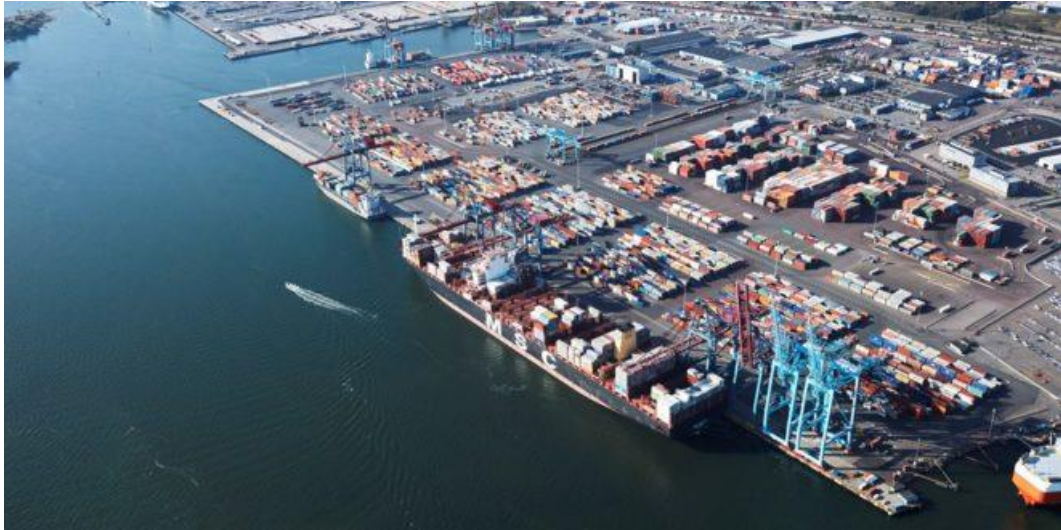
Slika 10. Intermodalni terminal Gothenburg
