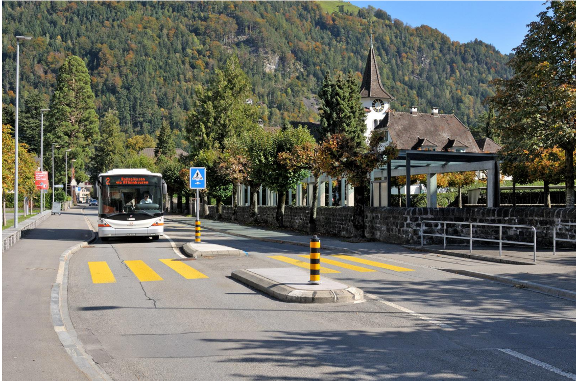
Fotografija 15 – Pješački otok za sigurniji prijelaz ulice kod osnovne škole, ulica Bahnhofstrasse, mjesto Altdorf, Švicarska, 2019.
