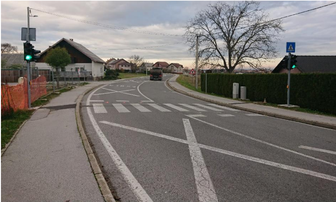
Slika 5.6. Semafori na pješačkom prijelazu u Topličkoj ulici prema Ulici učitelja Vjekoslava Kezele
