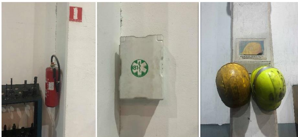
Slika 44. Protupožarni aparat, kutija prve pomoći i kacige
