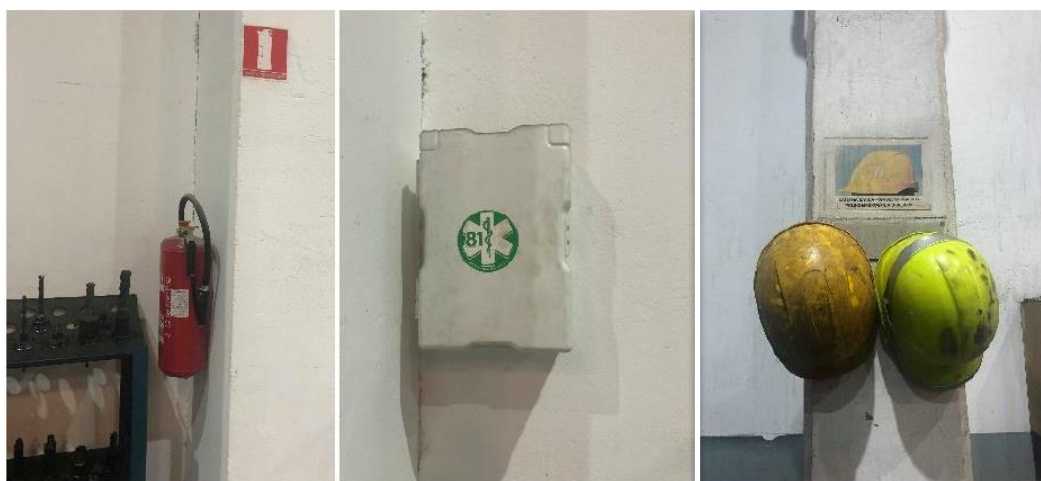
Slika 44. Protupožarni aparat, kutija prve pomoći i kacige
