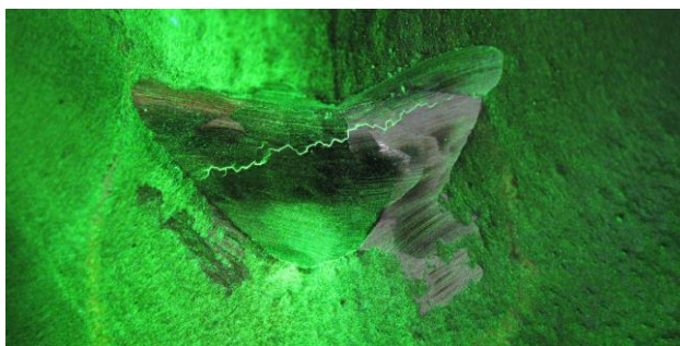
Slika 7 Pukotina zavara detektirana MT [7]
