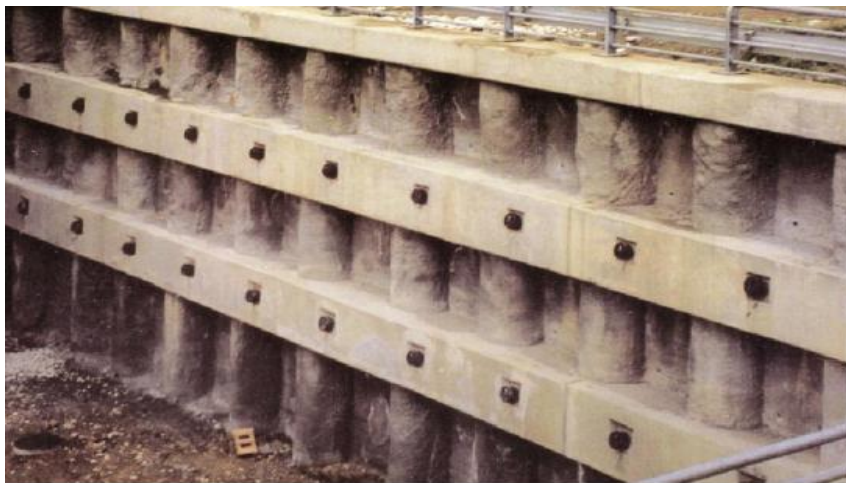
Slika 2.8. Prikaz otkopane konstrukcije izvedene pilotnim stijenama
