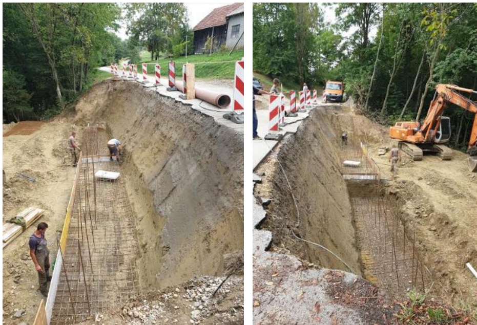
Slika 6.10. Izrada temelja za gabionski zid
