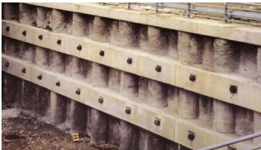
Slika 2.8. Prikaz otkopane konstrukcije izvedene pilotnim stijenama
