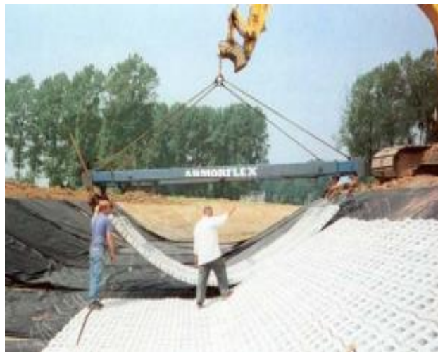
Slika 2.7. Kose obaloutvrde s oblogom od betonskih blokova[6]
