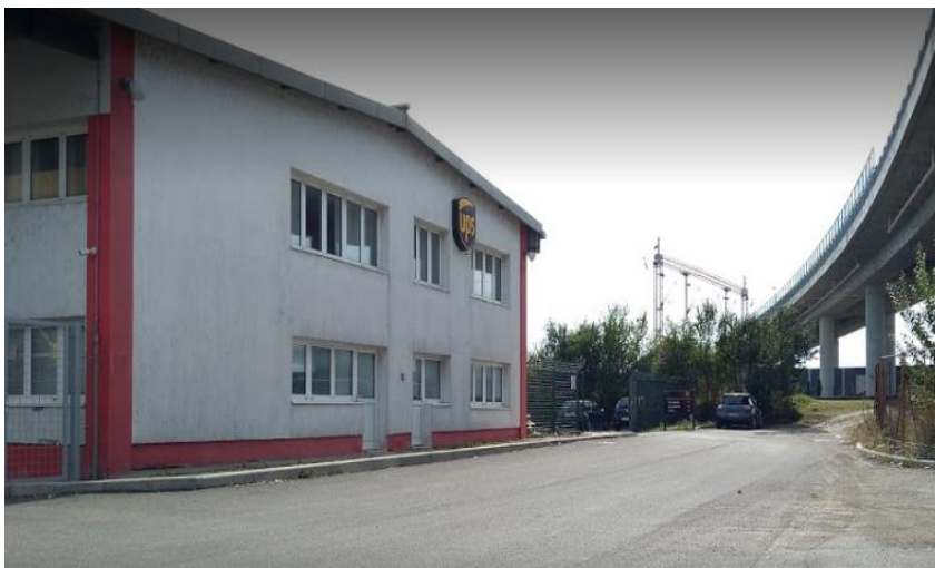
Slika 33. Skladište UPS-a u Velikoj Gorici (1)
