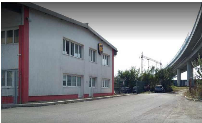
Slika 33. Skladište UPS-a u Velikoj Gorici (1)
