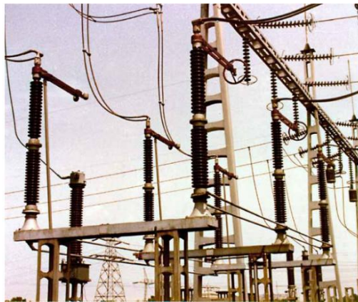
Slika 2.3 Dvostupni rastavljač sa središnjim rastavljanjem ( U_n 60 – 400 kV) [6]
